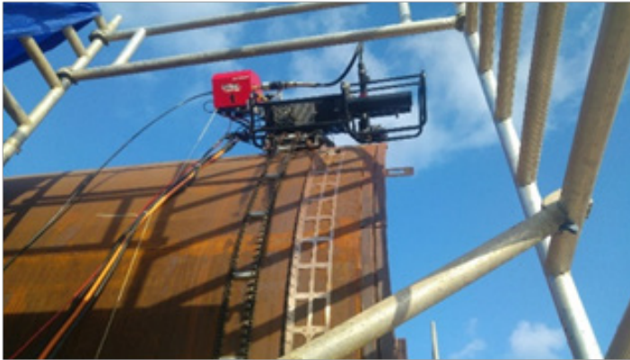
WOB 101 בריתוך צינור \varnothing 3000 מ"מ בעובי דופן 19 מ"מ
