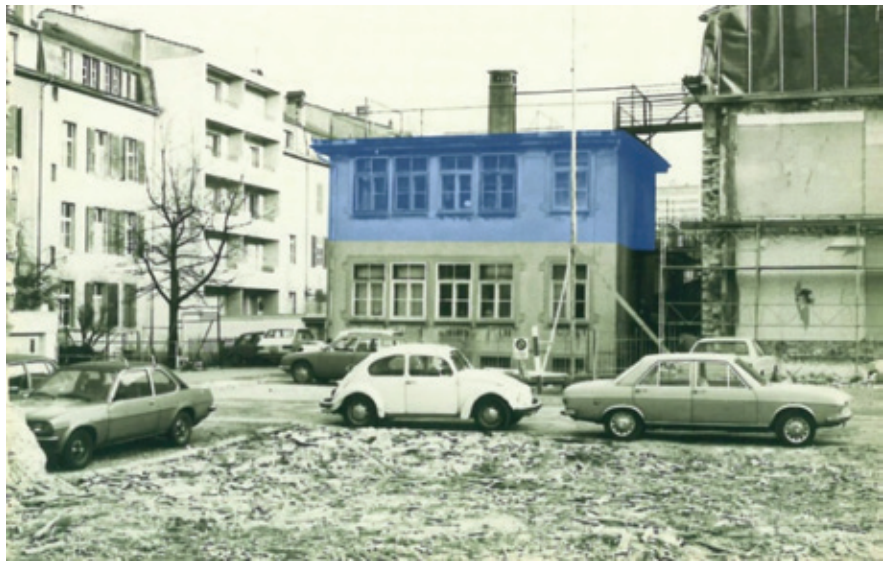
▲ La première maison de l'entreprise en tant que petit studio loué et un bureau dans un ancien bâtiment d'usine au centre de Biel
