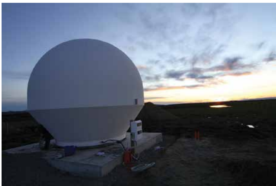
▲ תמונות 1+2. התקנה של תחנת קרקע למעקב אחר לוויינים זעירים בסביבה קוטבית (באדיבות אורביט מערכות תקשורת בע"מ.)
