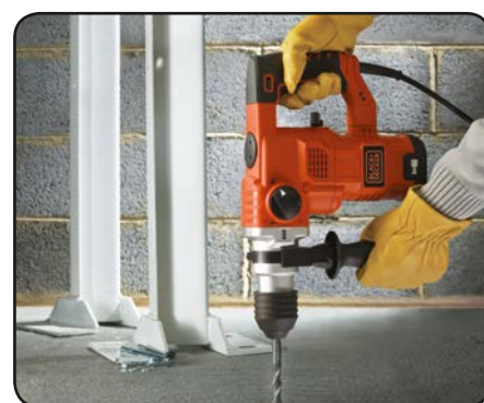
Percer dans la maçonnerie et le béton.
