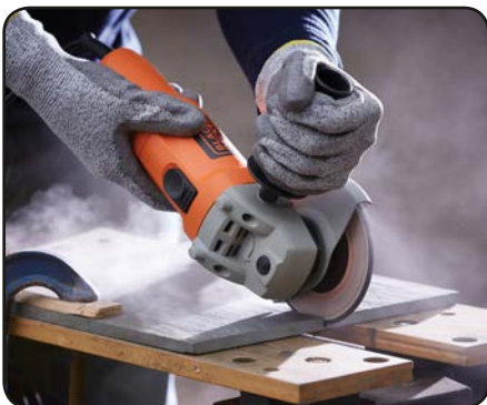
Enlever le mortier entre des briques.
