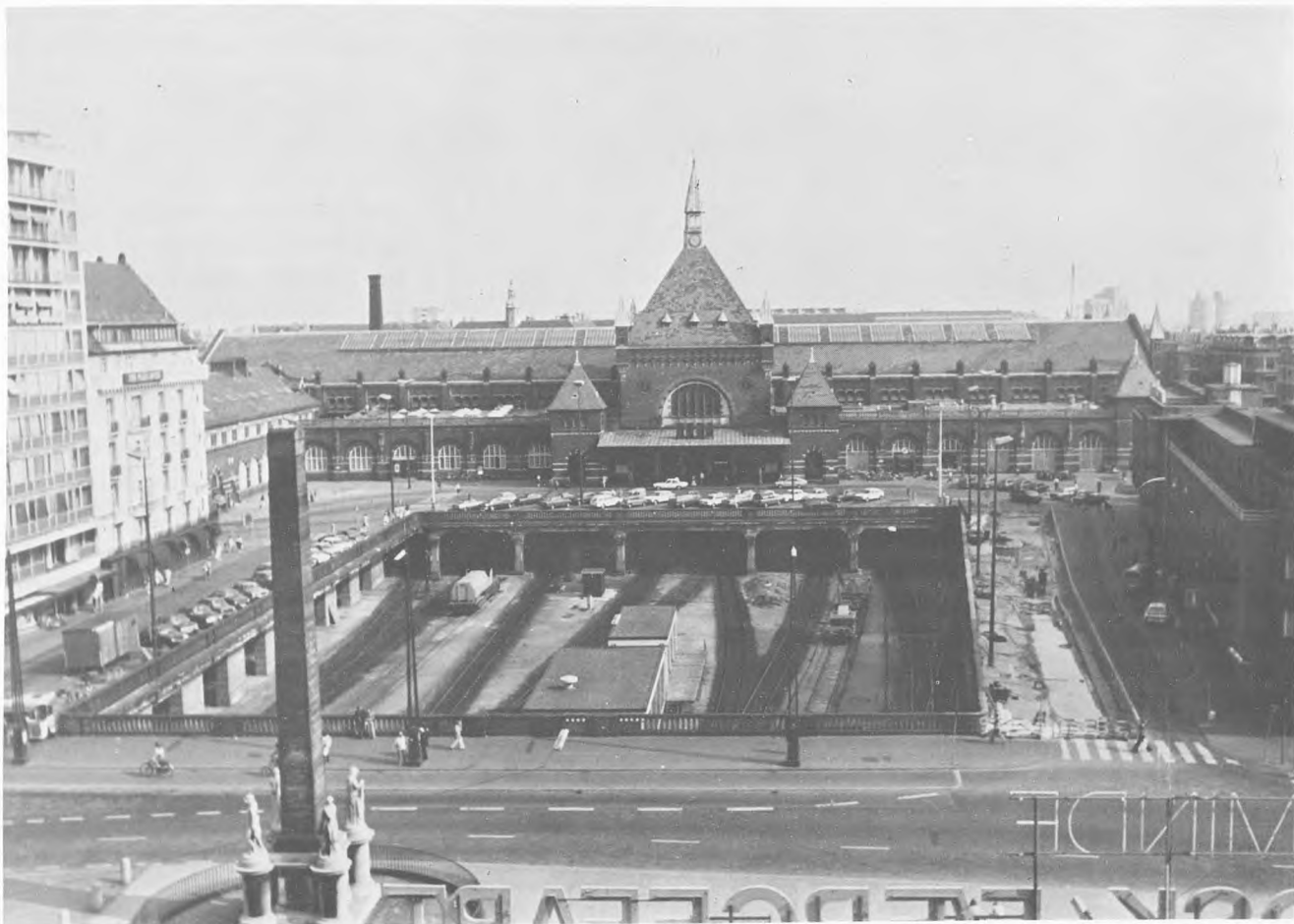
Udsigt over banegraven fra ejendommen Buen 1978
