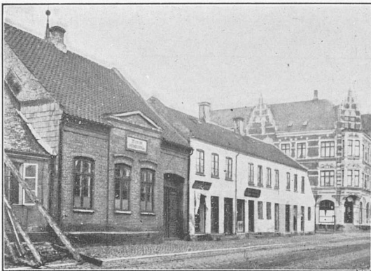
Den gamle St. Knuds Drengeskole i Fredericia. Opført 1865 af Pastor von Euch; nedbrudt 1905 for at give Plads til Bygningskomplekset »St. Knudsborg«.
