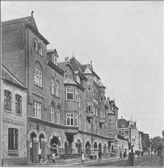
Komplekset »St. Knudsborg«. Opført 1905–06 efter Tegning af Arkitekt Jespersen.
