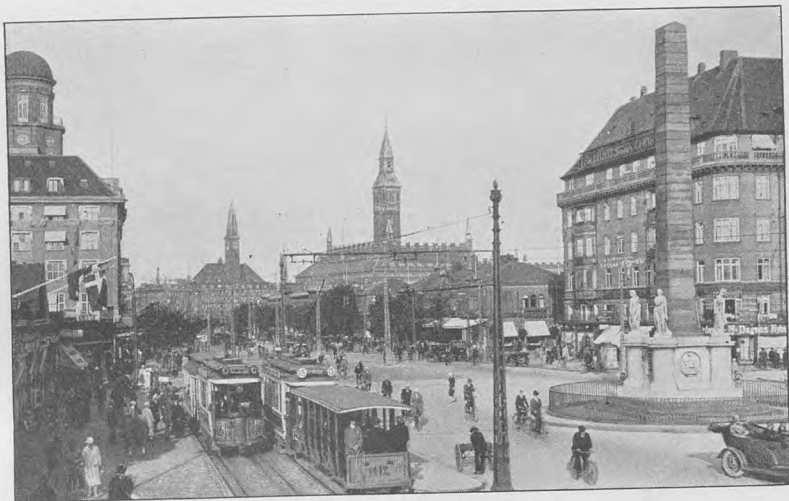
Vesterbrogade med Frihedsstøtten.
