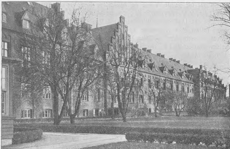
Diakonissestiftelsen, Hovedfløjen med den nye Tilbygning.
