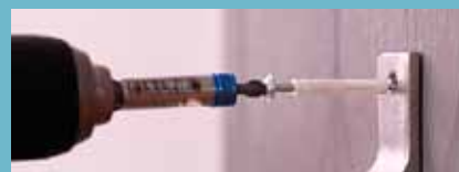
Du slipper förborra då pluggen är självborrande.
