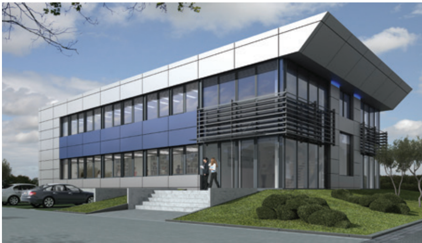
○ 新总部，屋顶光伏电站落成
