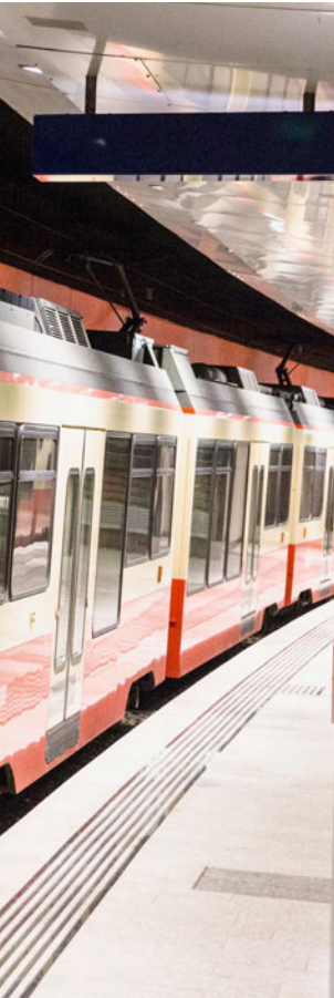
Die Tunnelhaltestelle Zumikon wurde 1976 eröffnet. Die Forchbahn unterfährt das Gemeindegebiet von Zumikon fast vollständig.
