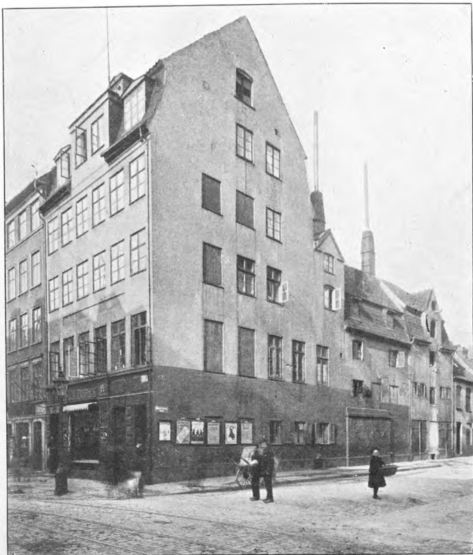
Ejendommen Store Kongensgade 91. Bagergaard siden 1682. Ombygget 1900.
