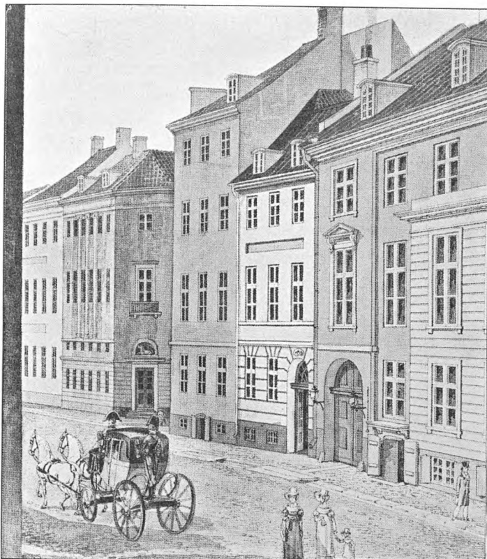
Ejendommen Vimmelskaftet 37. Siden 1680 har der været drevet Bageri paa Grunden.
