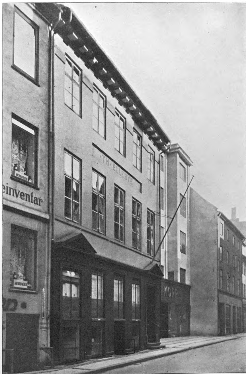
Ejendommen Læderstræde Nr. 26. Københavns Bagerlaugs Laugshus 1819-50.
