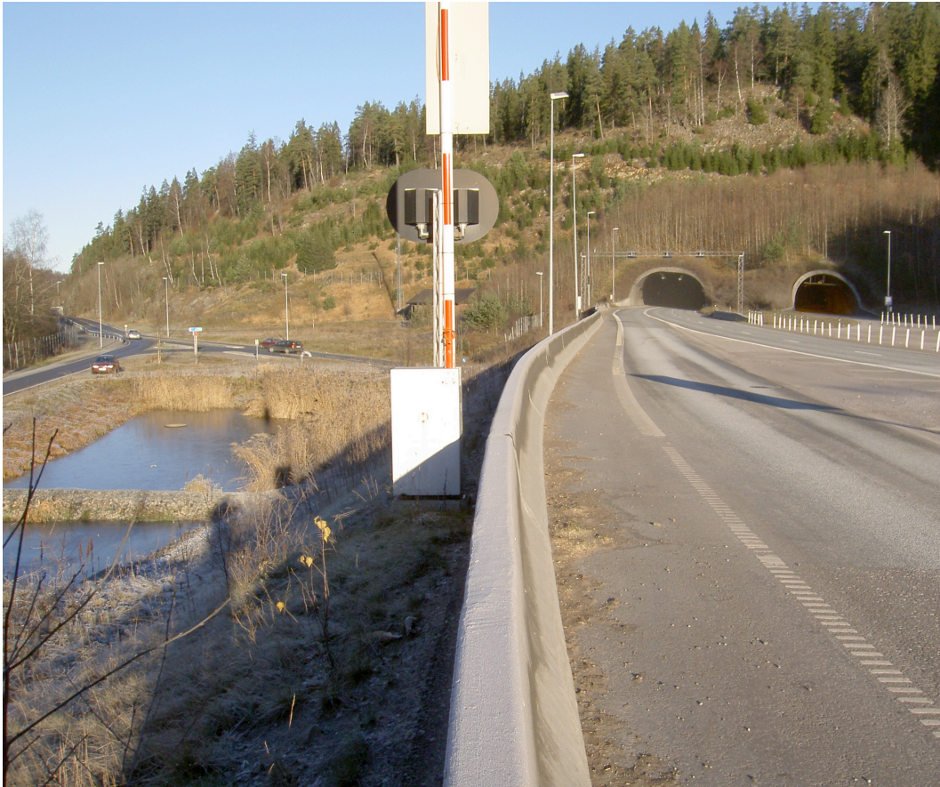
Fig. 2 Sedimentasjonsbasseng som tar imot avrenning fra tunnel og veg (Foto: Sondre Meland)
