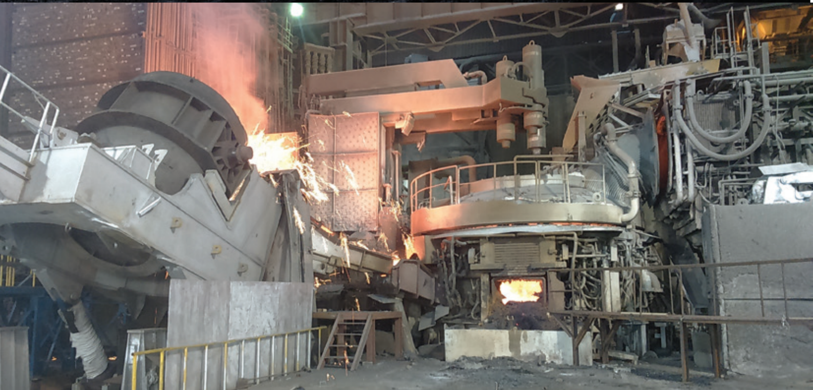
印度Raigarh Steel Plant炼钢厂的新熔炼炉
