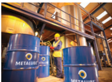
○ 场地中一个新的混合槽
