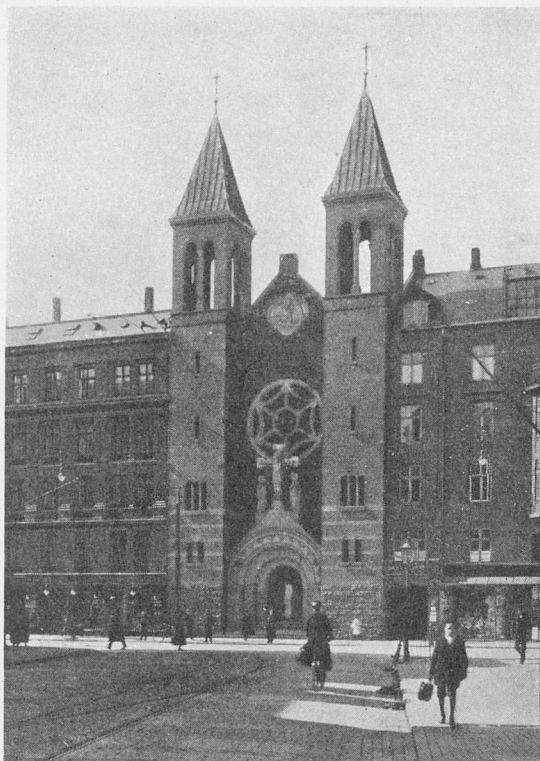
Sakramentskirken i 1917 før Klokkerne er opsat.
