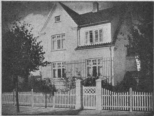
B/F. Broderskabet, Hus i Ahrenkildes Allé.
