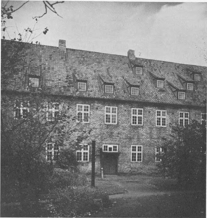
Fig. 29. Slavebygningen mod Stokhusgade før nedrivningen, set fra gården.
