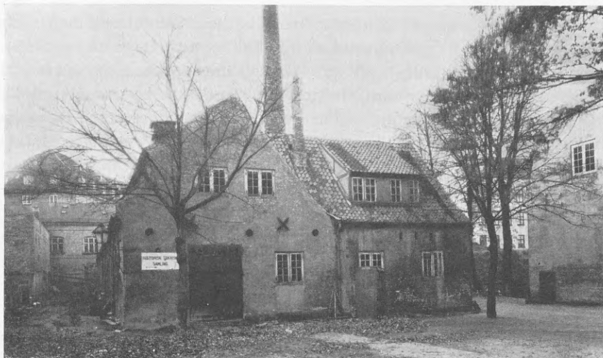
Fig. 21. Fruentimmerlazaret og vaskeribygning umiddelbart før nedbrydning.
