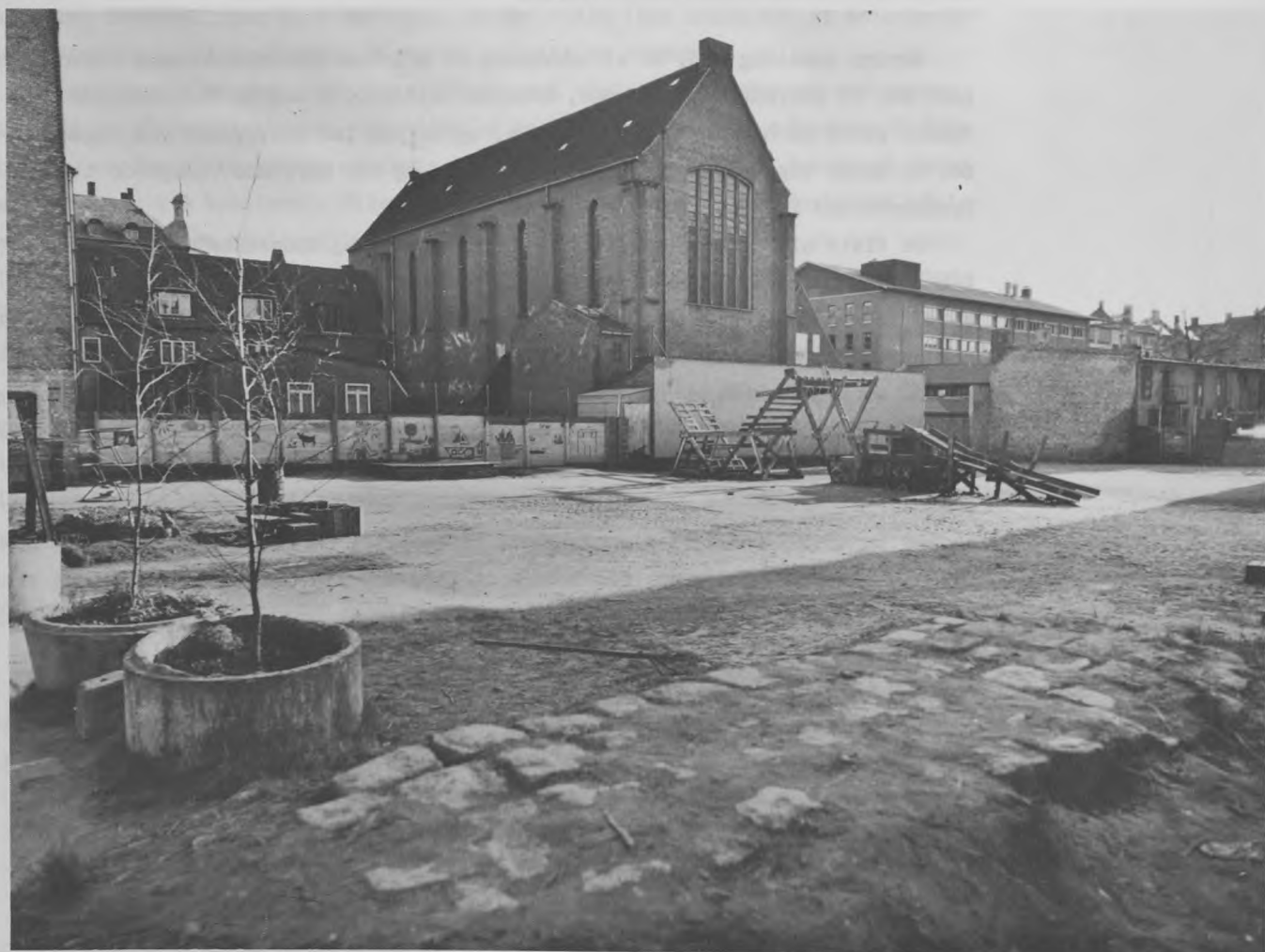
Byggelejepladsen på den lånte grund
