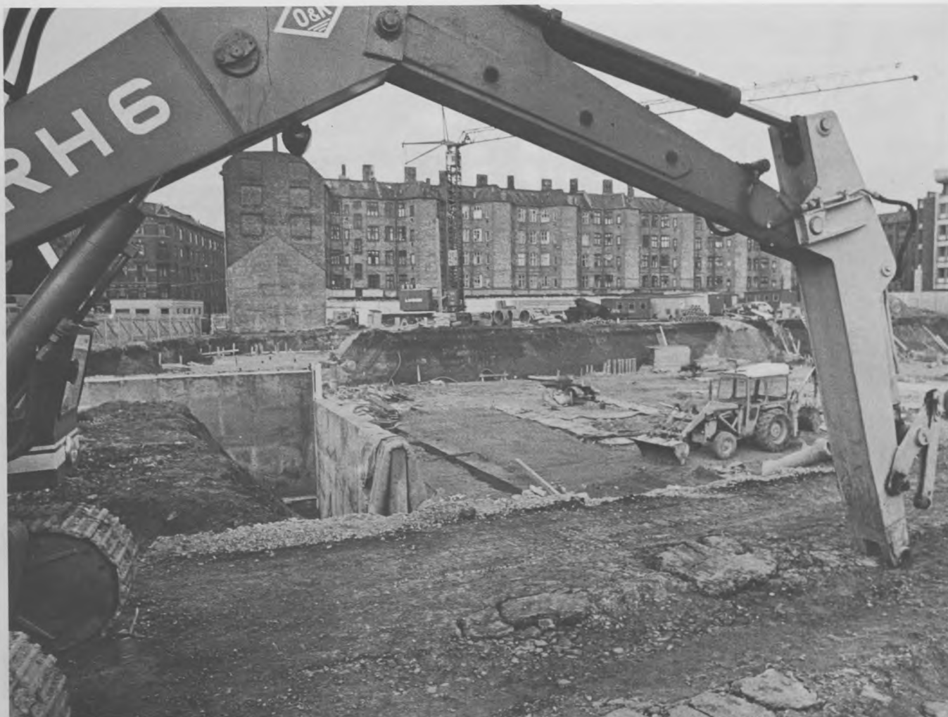
Først kommer gravkøen og støberiet - siden kommer "planen"
