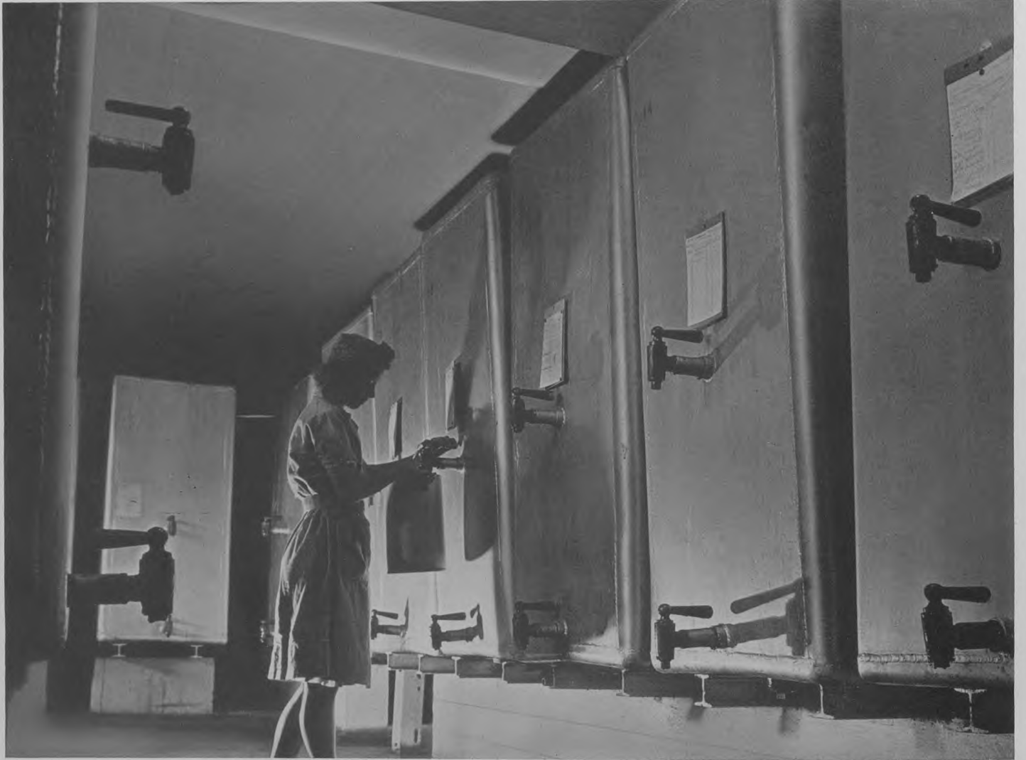
Et Hjørne med Lagertanke.
