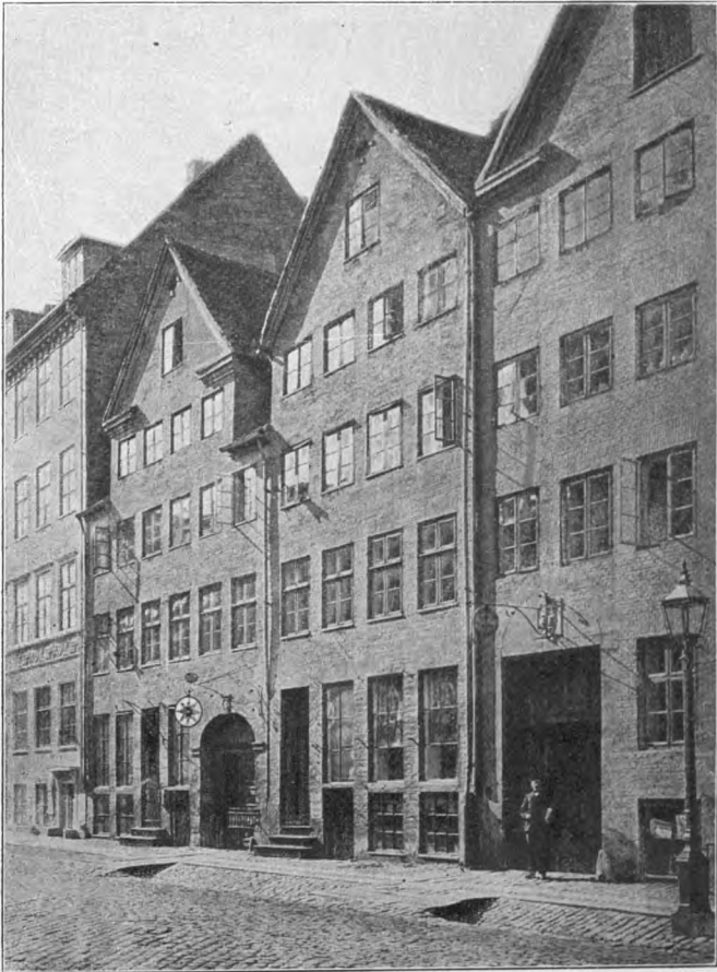
Fig. 8. Gavkvist og Front. Forsvundne Huse i St. Kongensgade. (Efter gl. Fot.).
