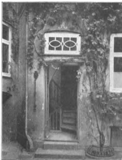
Opgang til Bagbygningen.
