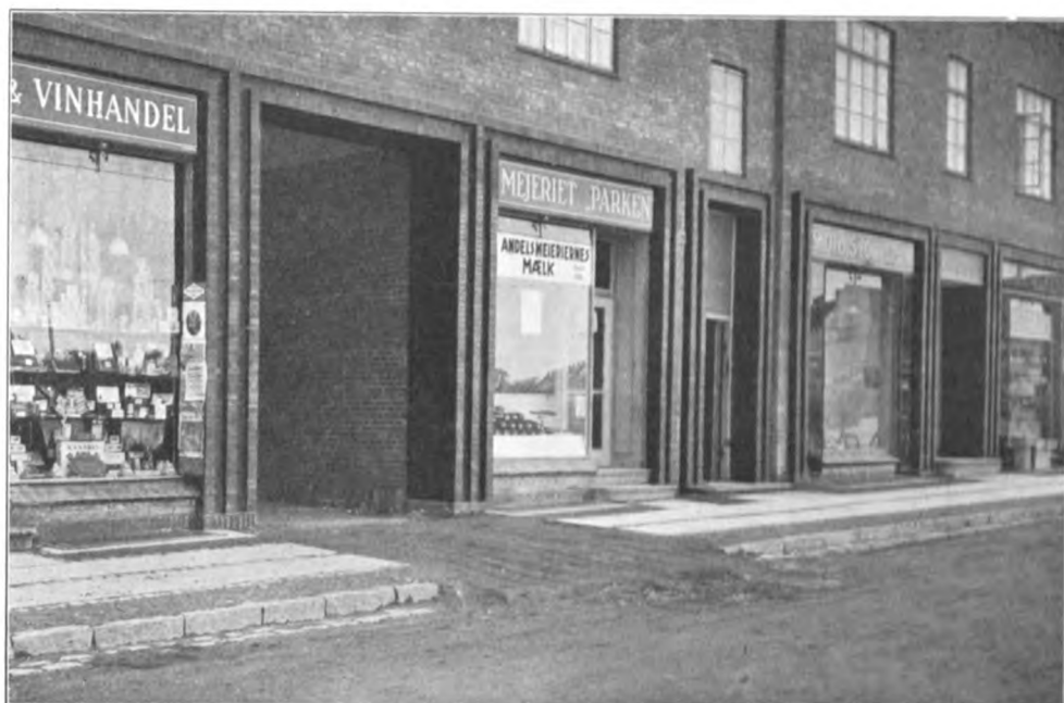
Ejendommen paa Hjørnet af Jagtvej og Parkallé. Arkitekt L. HYGOM.
