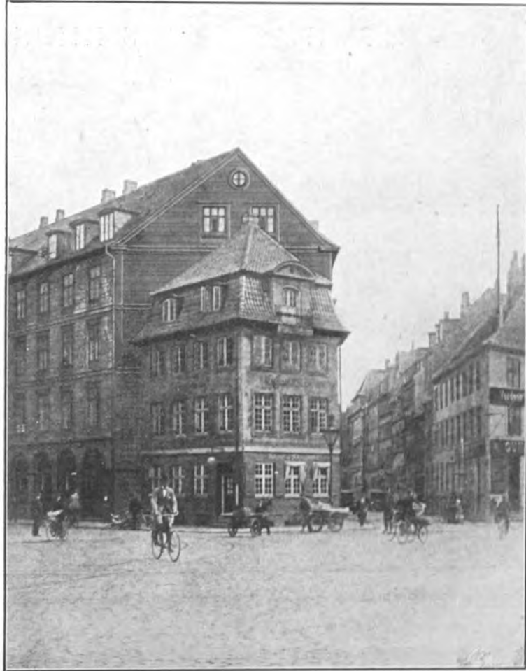
Arkitekt ALF. COCK-CLAUSENS Forslag til Ordningen af Gavlen bag det Kanneworff'ske Hus.
