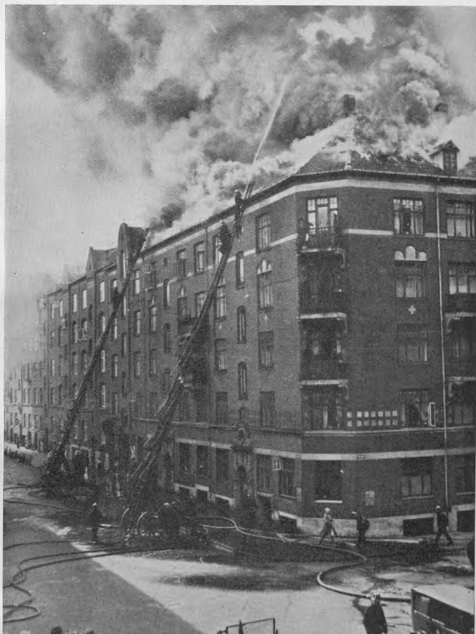
Tagbrand. Hj. af Søllerødgade og Holtegade 20. Juli 1934.
