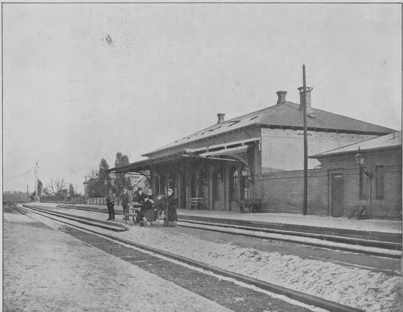
Frederiksberg Station, fra Vestsiden 1880'erne (opført 1864).
