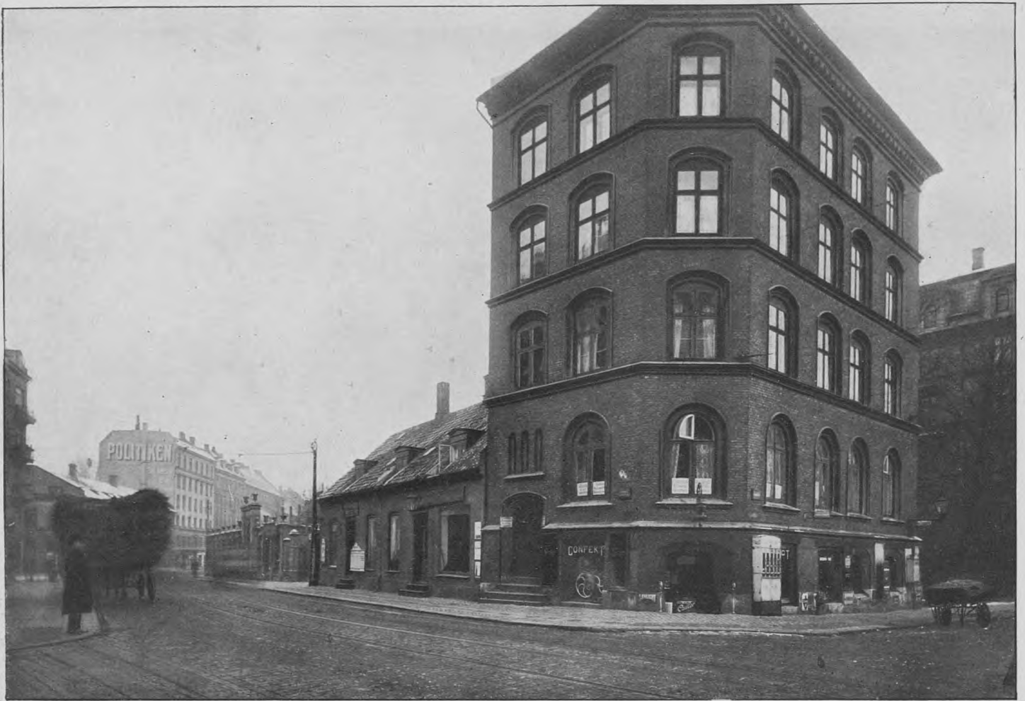
Ejendommen Hj. af Gl. Kongevej og Vodrofsvej, som i 1917 blev nedrevet for at give Plads for „Kinopalæet“, som ses paa næste Side.
