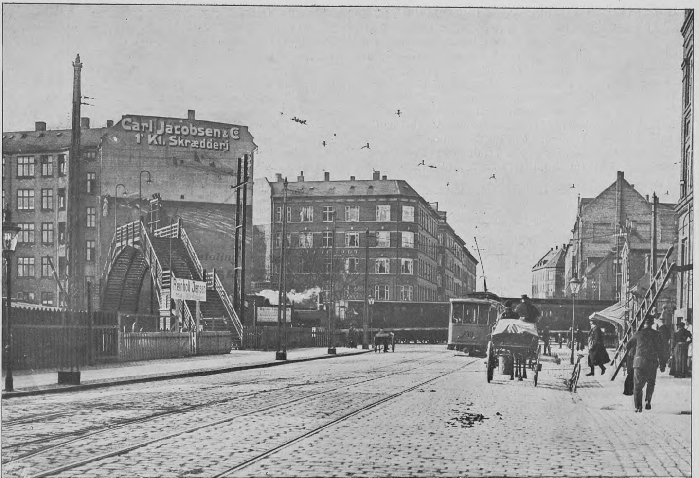
Parti af Nørrebrogade hvor Gaden skæres af Nordbanelinien. T. v. ses Gangbroen over Baneterrænet. 1913.
