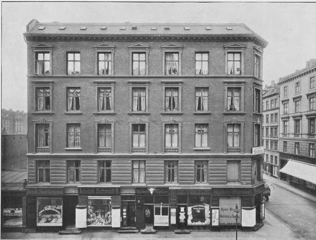
Fot. „Før og Nu“ ved Elfelt 1921.
