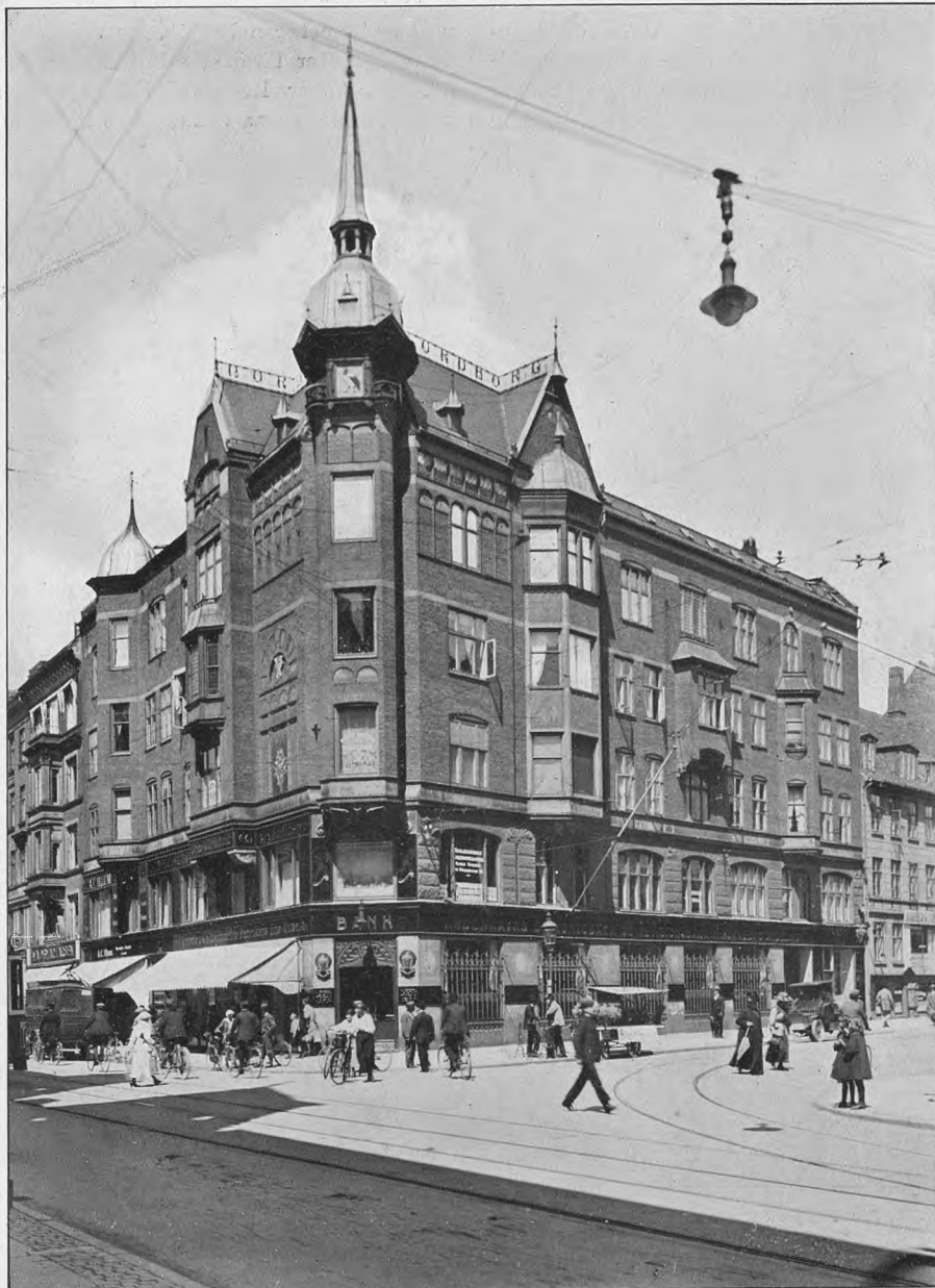
Fot. „Før og Nu“ ved Elfelt 1921.
