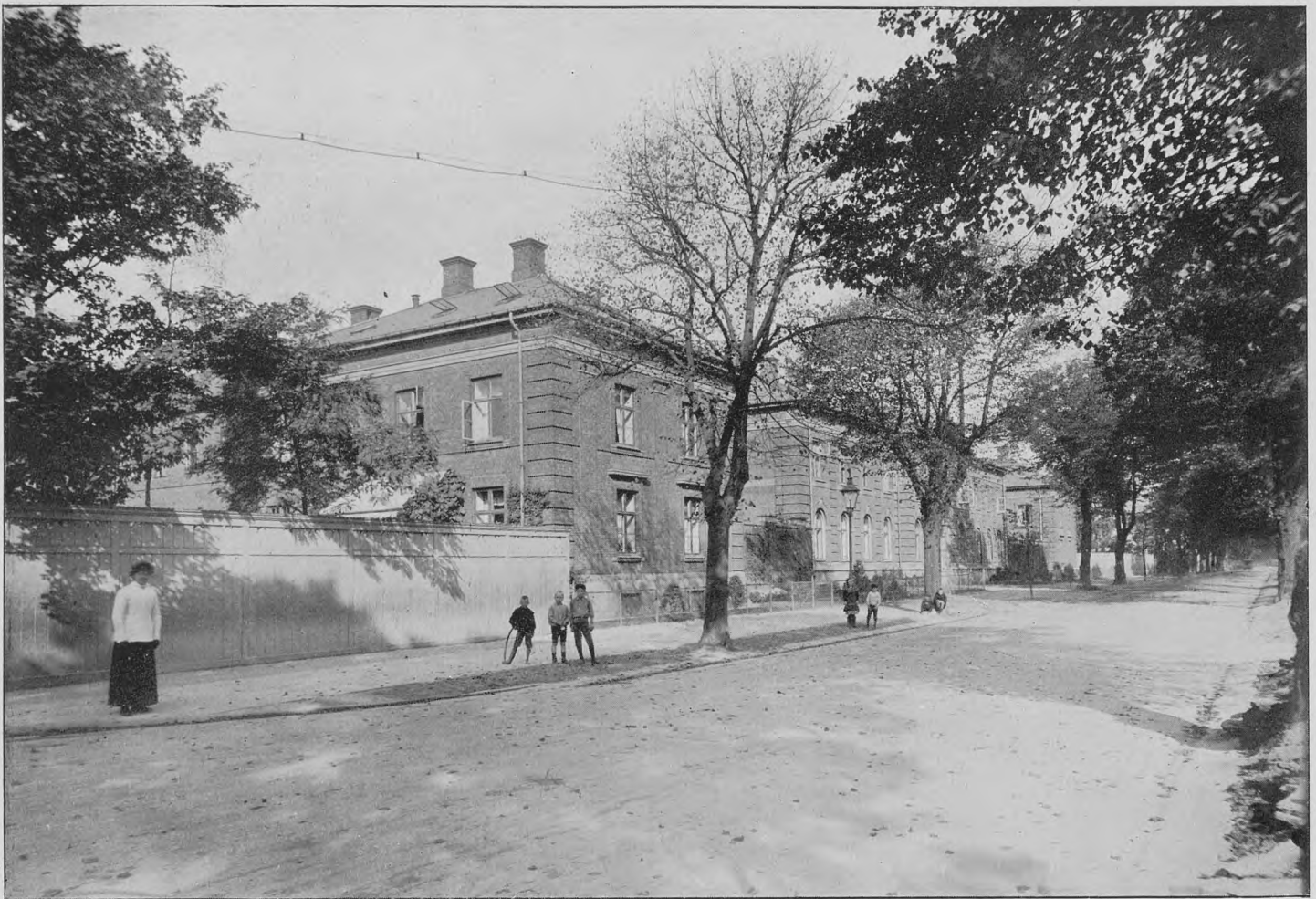
Nørre Allé udfør Almindelig Hospital (nu „De gamles By“), 1913. Tilvenstre i Alléen Hospitalets Administrations- og Funktionærbygninger.
