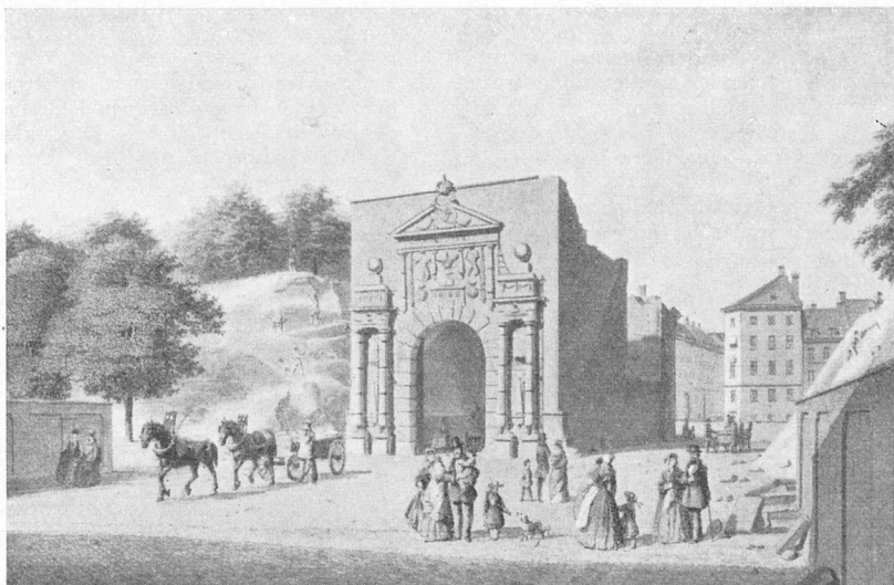
Vesterport under nedrivningen 1857.
