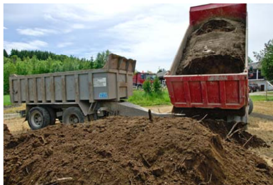
Kontroll av jord ved mottak må gjennomføres for å sikre at jorda leveres i henhold til bestilling. Foto: Erling Fløistad.
