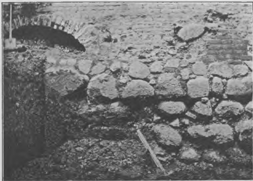
Fig. 8. Helligaandshusets Hegnsmur i Nordgrænsen. Fundamentet viser tydeligt den oprindelige Jordlinie; Murbuen til venstre er bygget over en Trævandledning efter 1728.
