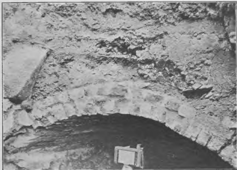
Fig. 7. Hvælving under Hestemøllen, set fra Gaarden. Façademuren er fjernet.
