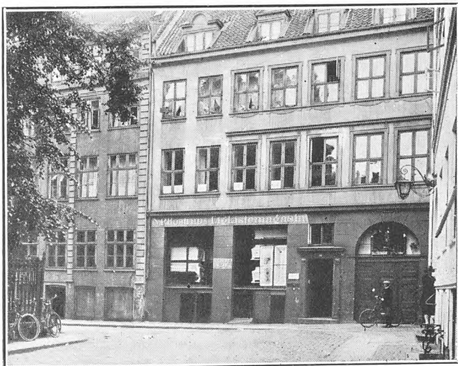
N. C. Rostrups Forretning, Valkendorffsgade 34—36.
