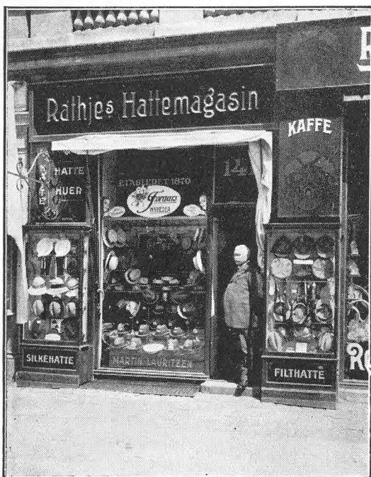
Rathjes Hattemagasin, Amagerbrogade 141.
