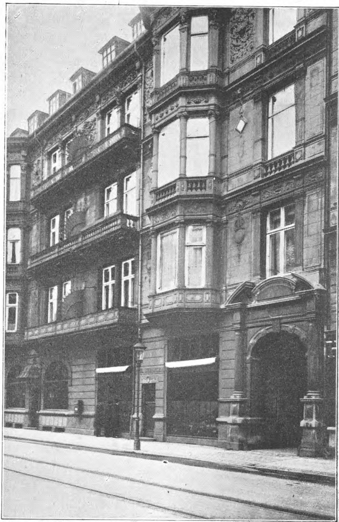
Den smukke Ejendom i Bredgade (Nr. 75) hvor Poul Sørensen har Forretning.
