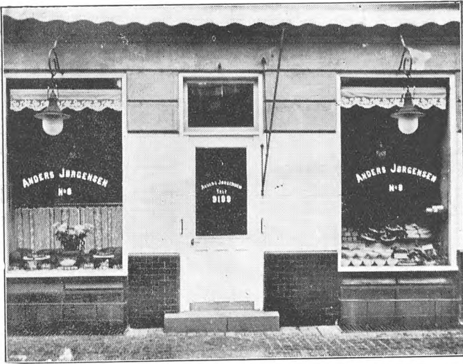
Facadebillede fra S. Jørgensens Forretning, kavnsborggade 8.
