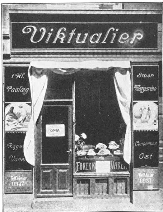
Frk. Marie Petersens Forretning, Dybbølgade 38.
