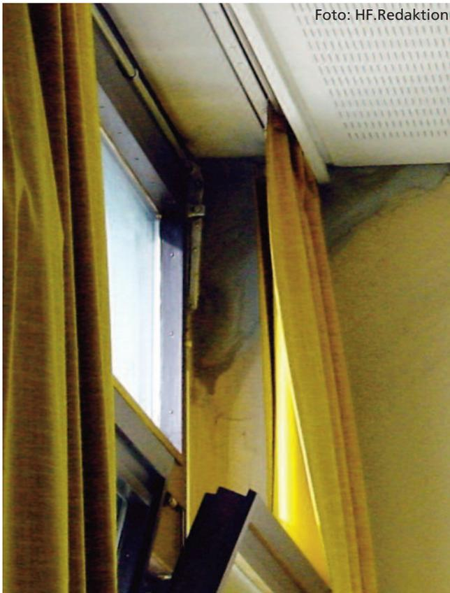
Wenn der Architekt auf die vollflächige Luftdichtheitsschicht verzichtet, ist er mit einem Planungsfehler in der Haftung.
