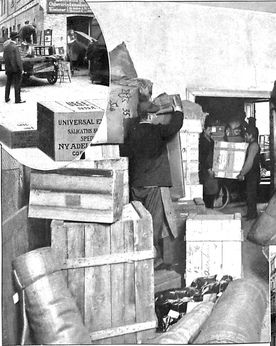
Interior fra Pakhuset.
