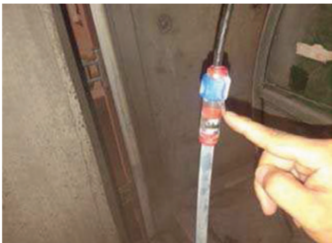
图5: 端盖周围的水冻结
