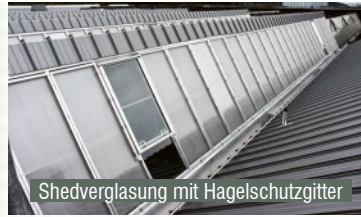
Sanierungen von Sheddächern
