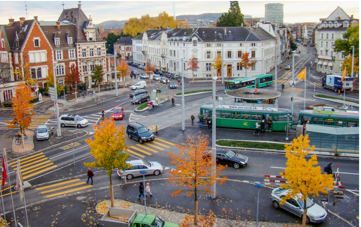
Herbststimmung am Wettsteinplatz: Die Bäume sind unterschiedlichen Belastungen wie Abgase, Lärm und auch der Verdichtung ausgesetzt. Luftkanäle sorgen dafür, dass die Wurzeln auch in drei Metern Tiefe ausreichend Sauerstoff erhalten. Bild: Stadtgärtnerei Basel
