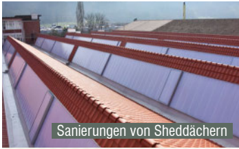
Shedverglasung mit Hagelschutzgitter
