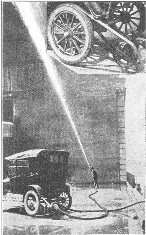
Den lille Ellehammer-Brandsprøjte. Ydeevne: 250 Minutlitter
