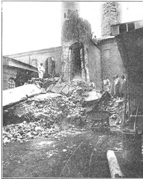
En Skorsten væltet paa Aalborg Portland Cementfabrik.
