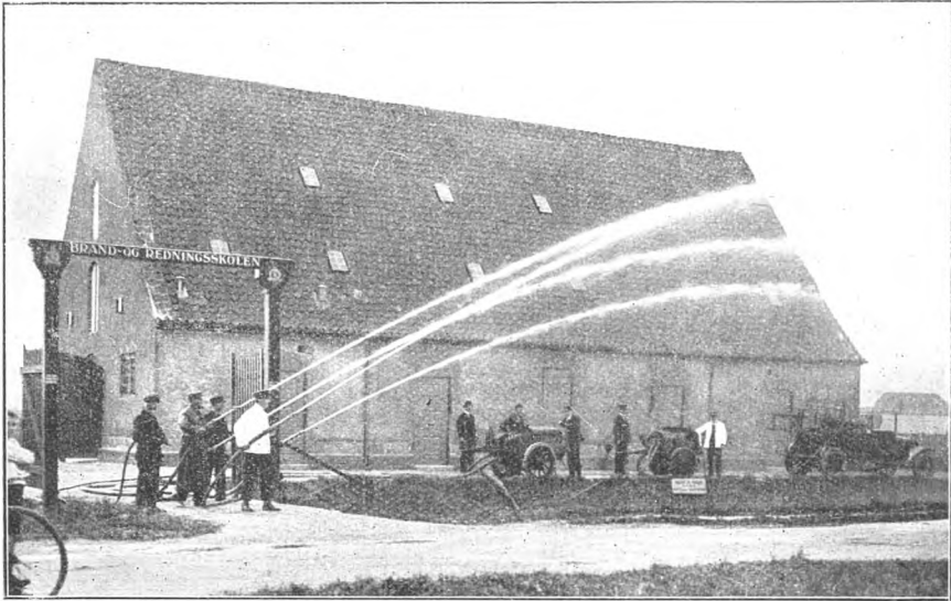
Brand- og Redningskolens Hovedbygning. I Forgrunden Slukningsøvelser.
