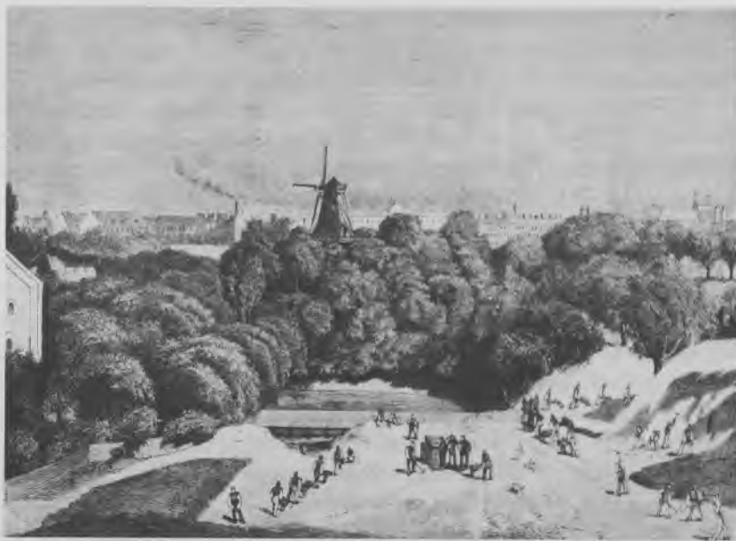
Fra voldsløjfningsarbejdet. Illustreret Tidende 1879-80, s. 520.
