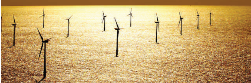
▲ Offshore-Windpark Horns Rev 2 von Dong Energy (Bild mit freundlicher Genehmigung von Elsam A/S)
