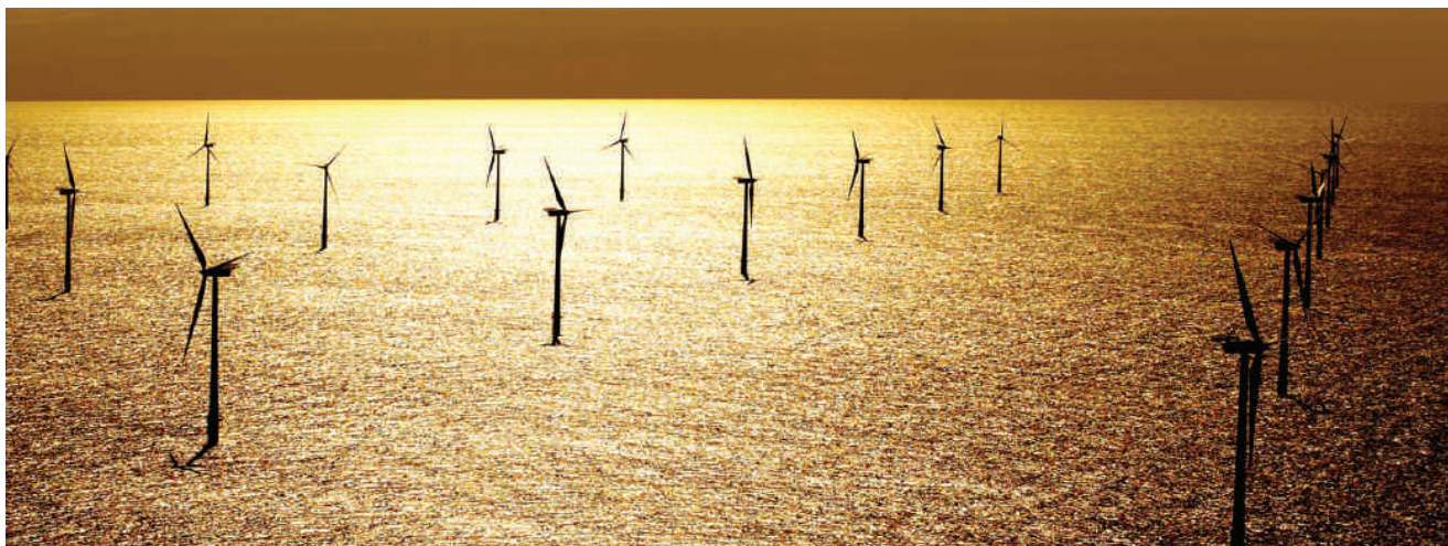
▲ Parque éolien offshore Horns Rev 2 de Dong Energy (Photo avec l'autorisation de Elsam A/S)
