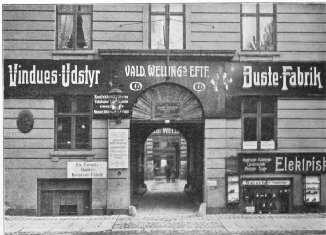
Indgangen til Ejendommen St. Kongensgade Nr. 108.
