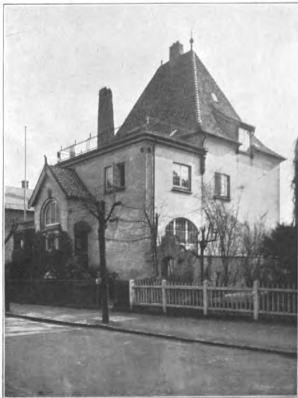
1904. Villa paa Kong Georgsvej (Arch. A. Rosen).
