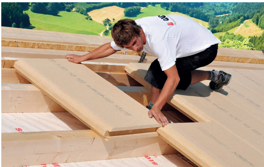
Verlegung von Ultratherm-Unterdeckplatten.
