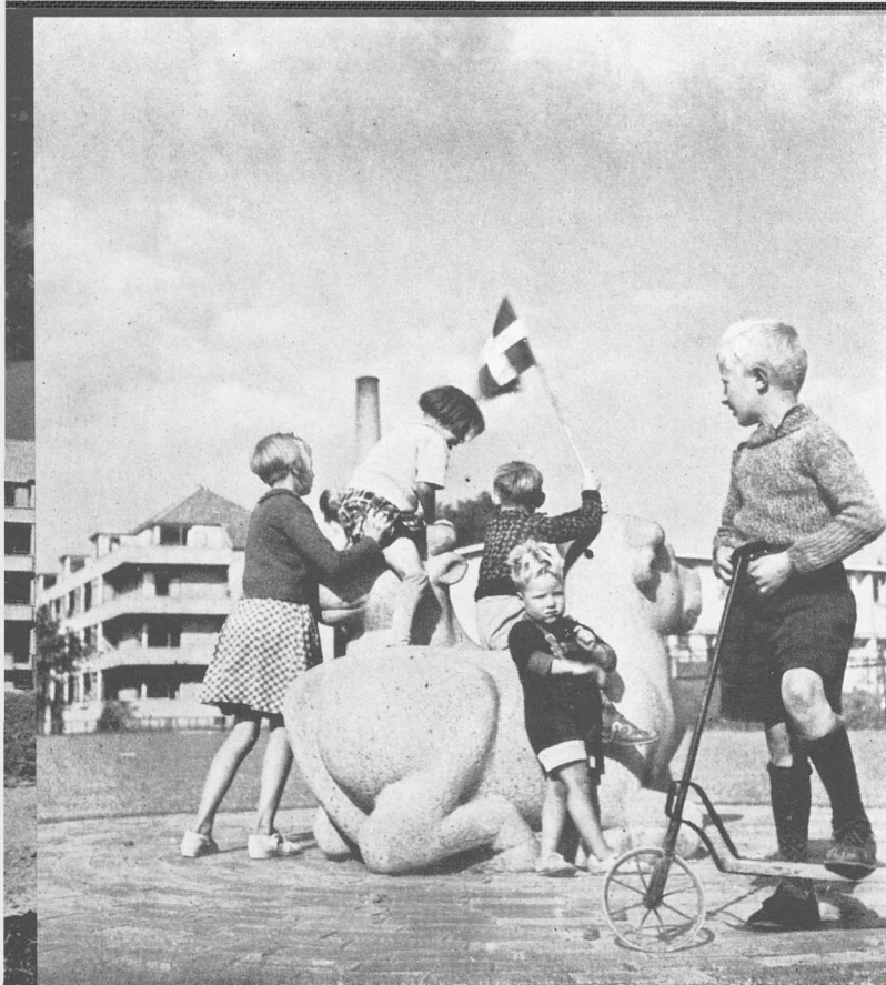
I det aabne bælte langs Bollegaards Allé mellem rækkebusene er der opstillet en figur af to tyrekalve bugget i granit af billedhugger Henrik Starcke. Tyrene er allerede ved at blive blanke af de mange børns leg. I baggrunden til venstre blok 1 og til højre blok 10.
