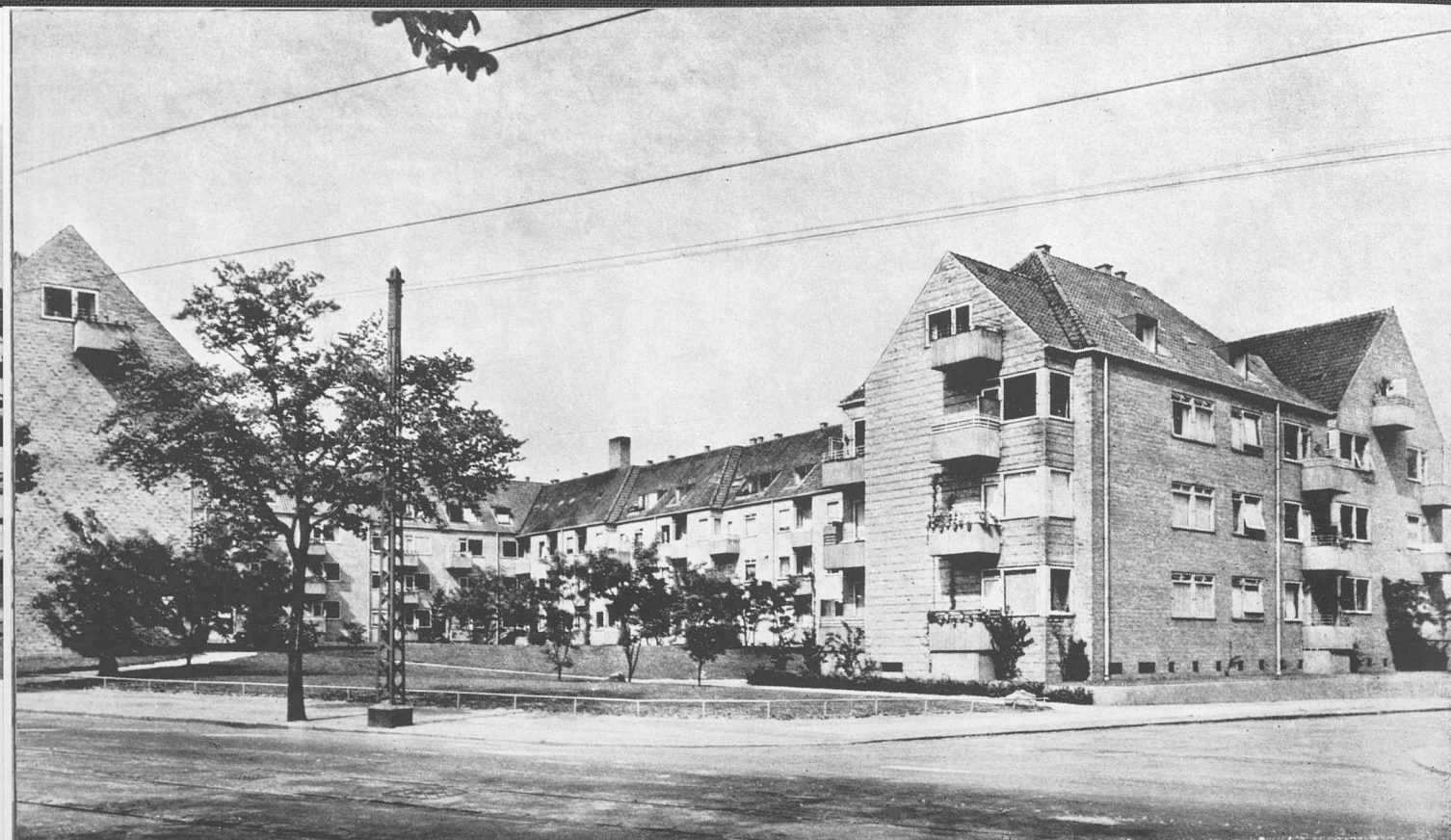
Provstegaarden set fra syd-vest fra Tagensvej. Midt i bebyggelsen ligger et stort haveareal med uindhegnede plæner og fritstaaende træer. Arealet er noget kuperet med fald mod syd. Murværket i gavlene er udført i mønster.
