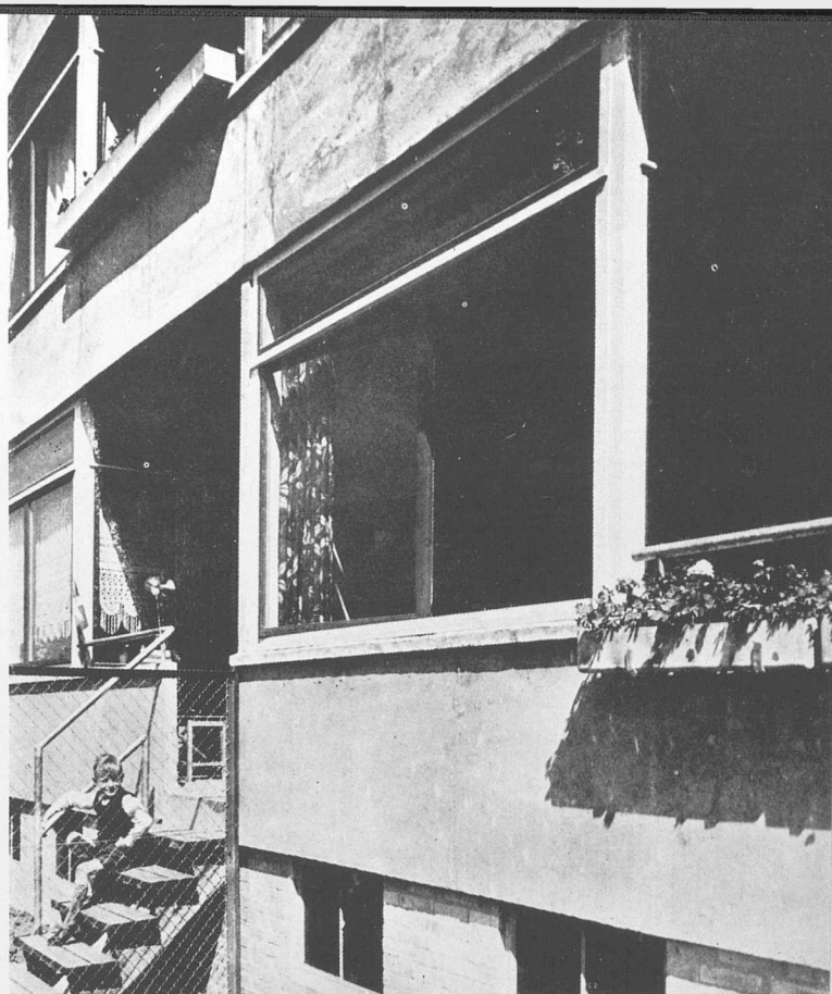
Karnapvindue fra blok 2.
