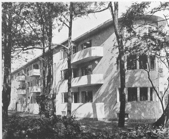
Blok 11 set fra sydvest. Sydvæggen i spisestuen er halvcirkulær med vindue hele vejen rundt.
