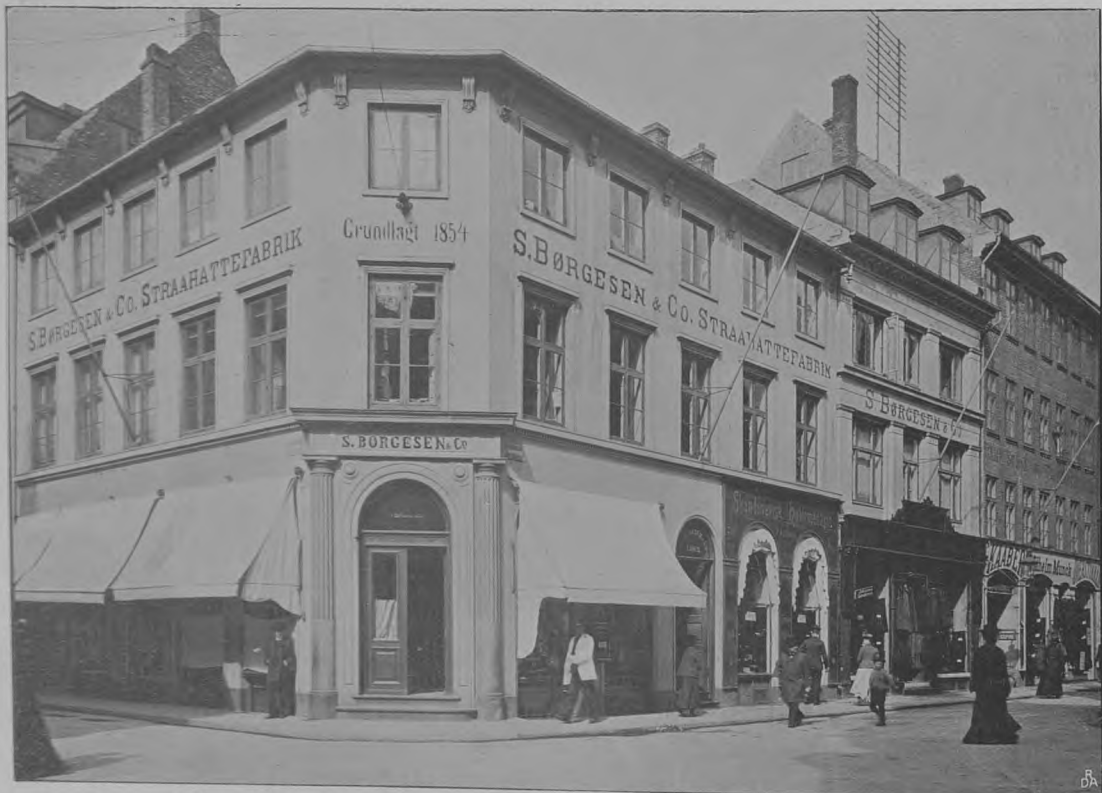
DE GAMLE FORRETNINGSBYGNINGER I PILESTRÆDE OG SILKEGADE
