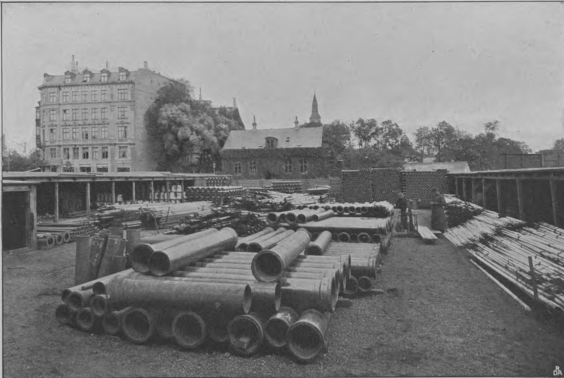
RØRPLADSEN I REVENTLOWSGADE
