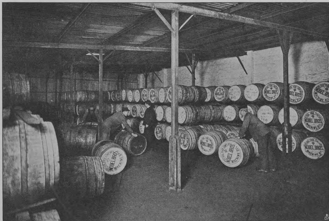
INTERIØR FRA TRANSITLAGERET
