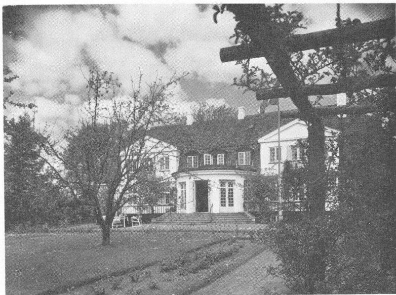
Helene Michaelsens Hjem for ældre kvinder beliggende Ermelundsvej 101 i Gentofte. Den store villa blev skænket til Københavns kommune i 1921 af direktør Ernst Michaelsen og hustru (jfr. s. 98 f.). Administrationen varetages fra De Gamles By. (Strüwing. Fot.).
