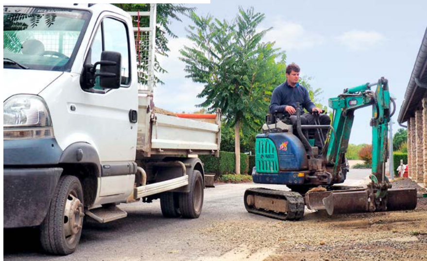
Maçonnerie Maxime Boudesseul, Benest (16)
