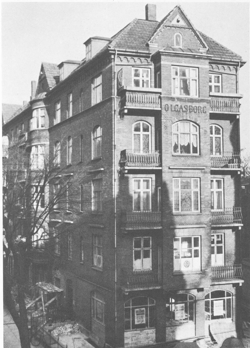
Olgasborg under ombygning i 1952.
