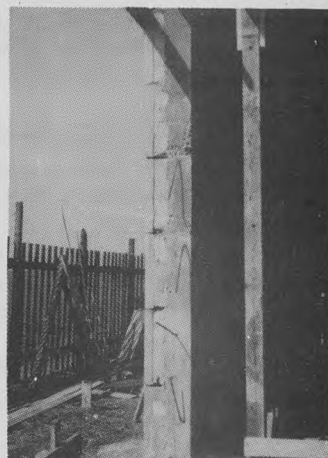
Vestgavl afformet. Udvendigt travisolblokke med betonforstøbning, indvendigt 14 cm grovbeton.
