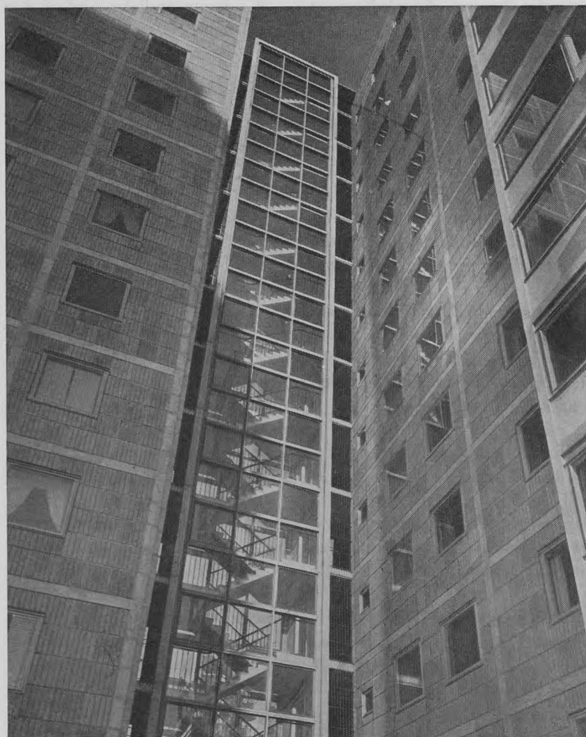
Fig. 1. Et af KAB's buse med trappepartiet mellem de to »halvbuse«.
