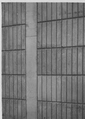
Vestgavl. Væggen afforskallet. Man ser de lodrette bånd støbt i hvid beton. Væggen består af blokke 42 x 42 cm.
