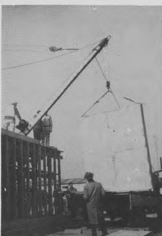
Østgavl. Montering af et gavlelement i stueetagen ved anvendelse af "tilt-up" master.
