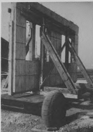
Et af de store facadeelementer transporteret på blok-vogn.
