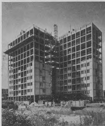
Fig. 2. Kaltonhus under opførelse.
