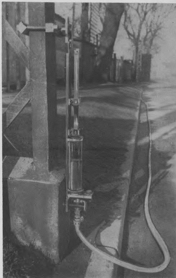
Fig. 2. Sætningsobservationer udføres med hydrostatisk nivellerinstrument.
