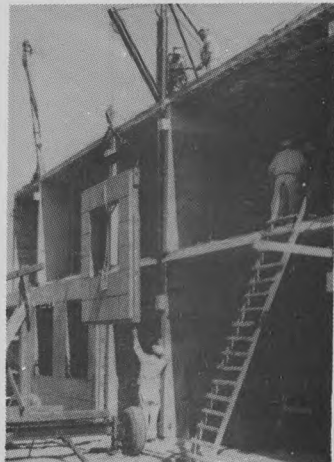
Facadeelementer. 3 stadier fra elementets ophejsning og anbringelse.
