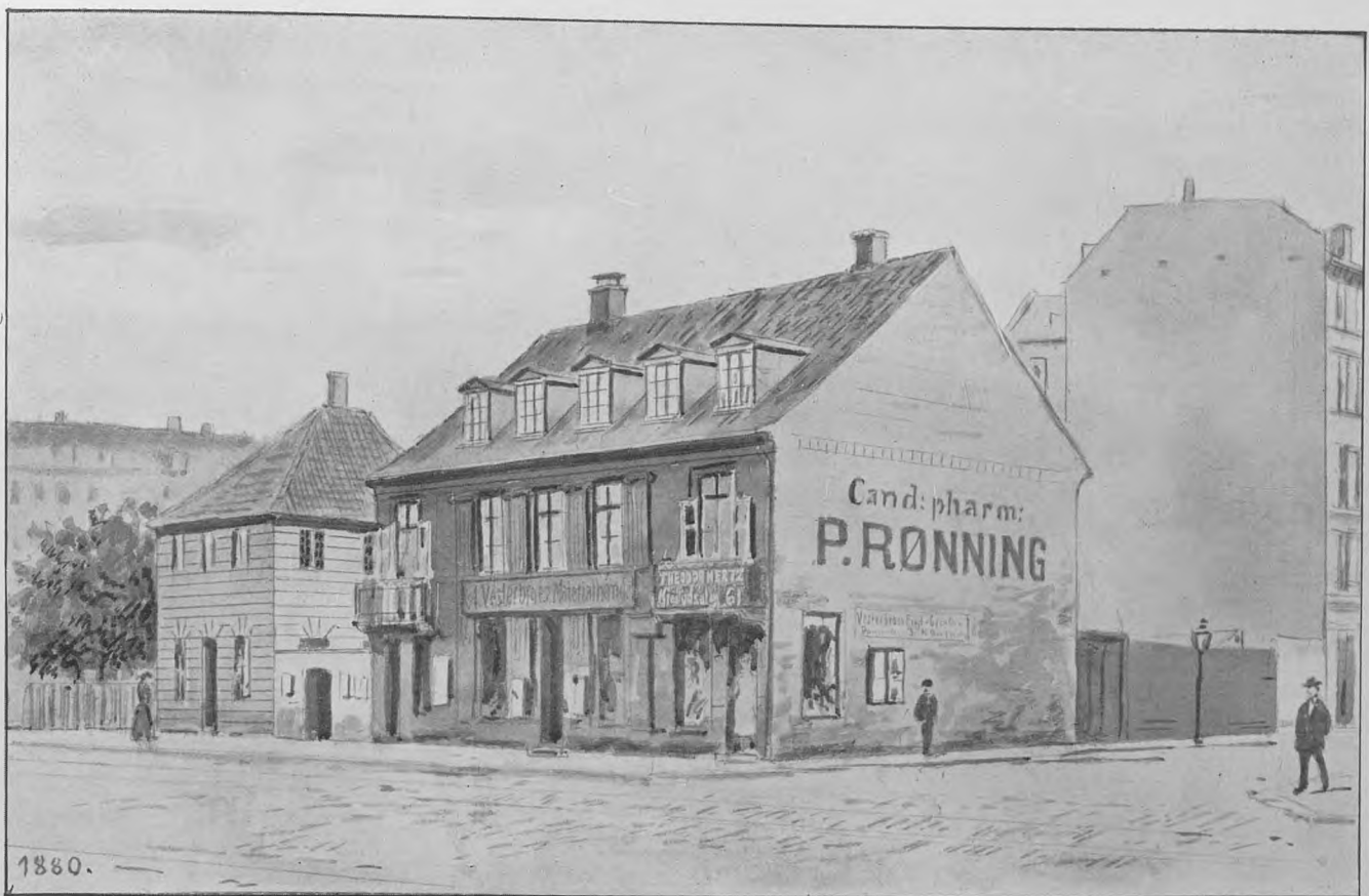
Hj. af Vesterbrogade og Dannebrogsgade, Aar 1880. T. v. Den kgl. Skydebanes Restaurationsbygning.
