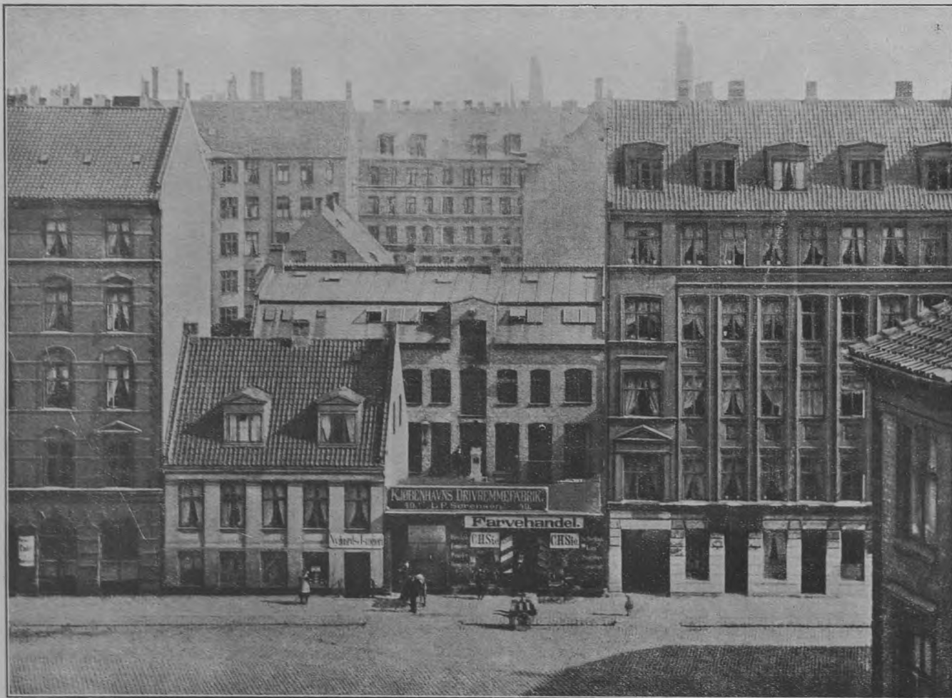
Vesterbrogade Nr. 47, tøj. af Gasværksvej.
