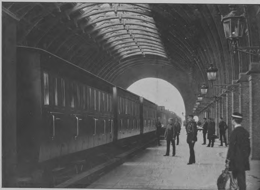
Perronhallen i ovennævnte Station (Afgangssiden).
