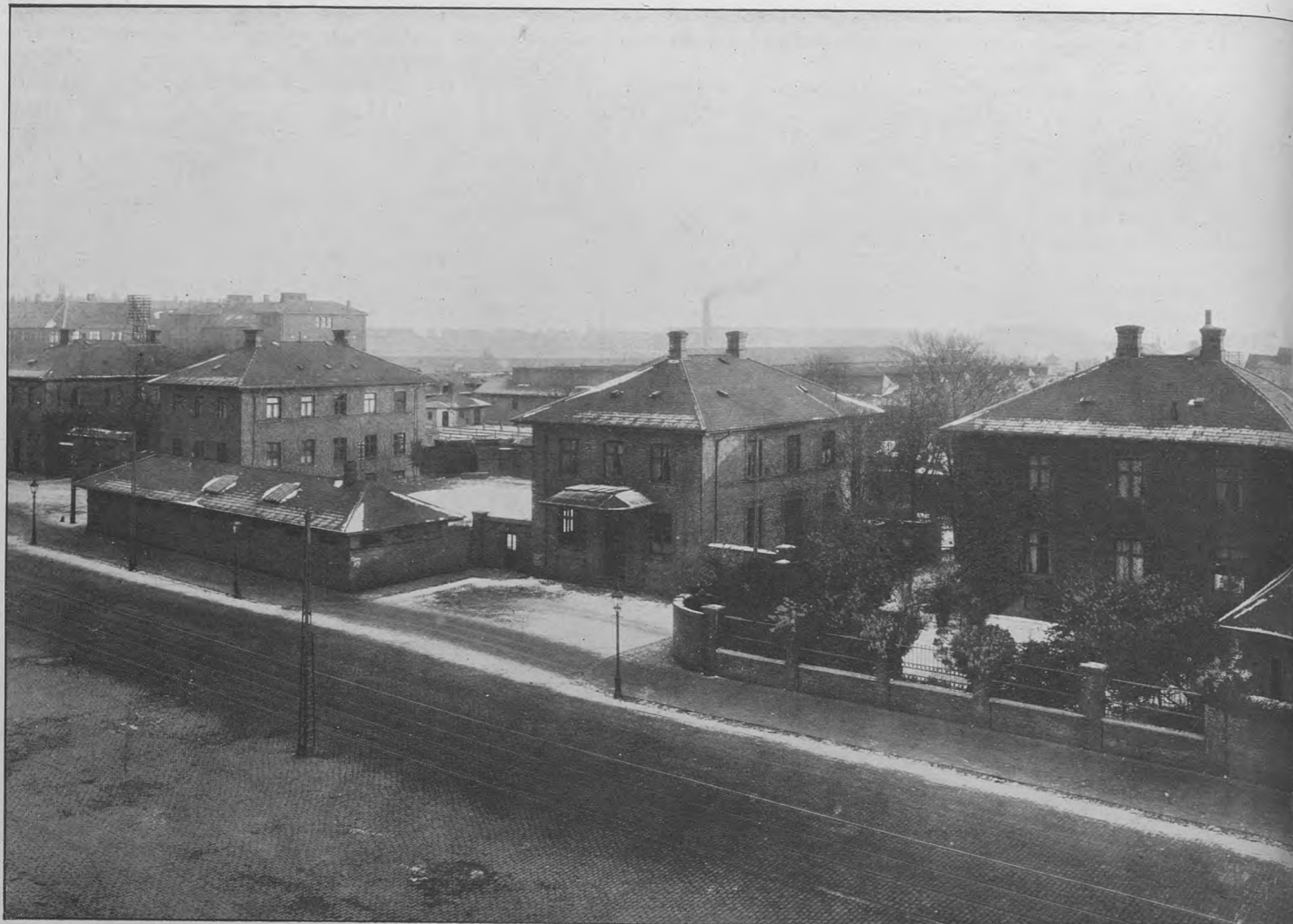
Fot. „Før og Nu“. Restaurations. Administrationsbygning.
