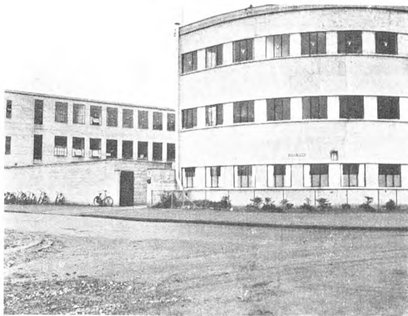
En anden Fabrik paa Amager.
