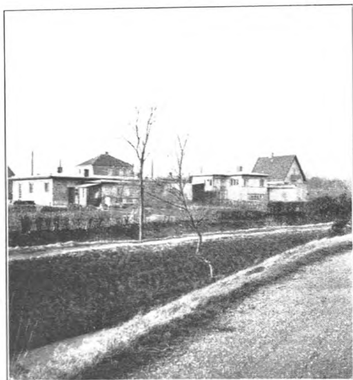
Parti af Bebyggelse Vest for Søen. Billedet er taget fra Dæmningen nærmest Søen, den anden Dæmning ses i Forgrunden og bag denne Tjørnehækken, der markerer Skellet ind mod Haverne.
