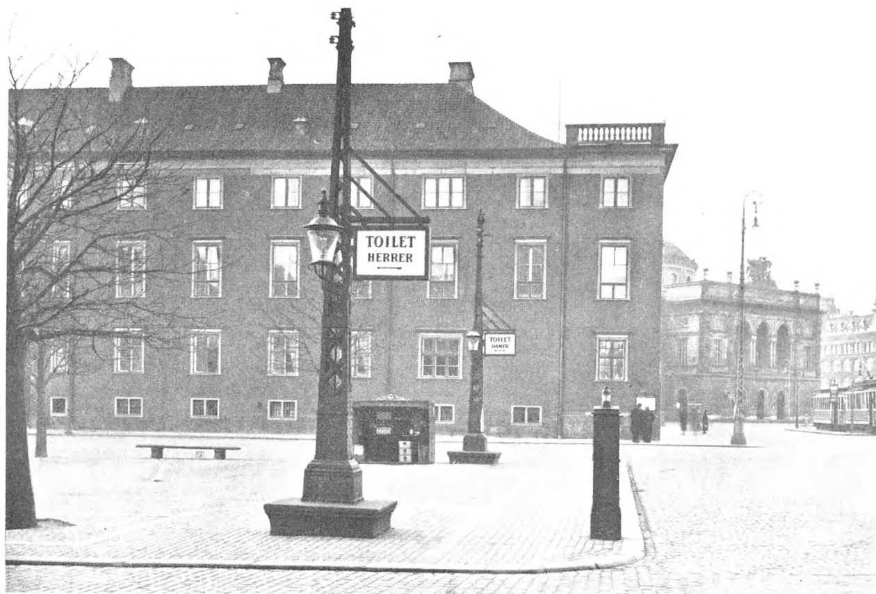
Charlottenborg set fra Bredgadehjørnet.
