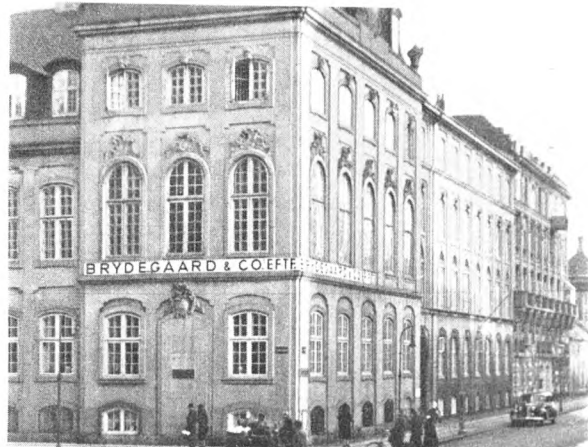
Hjørnebygningen Bredgade—Frederiksgade 17. Bygningen er fredet i Klasse A.
