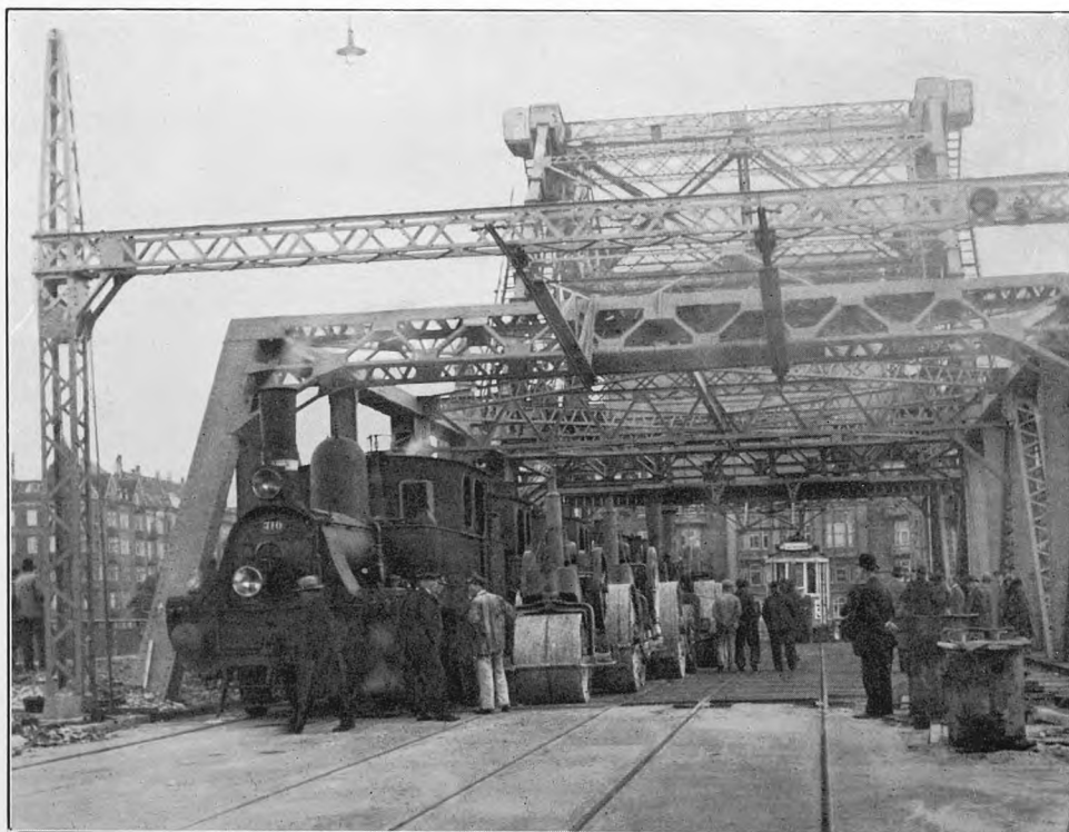
Interimsbroens Klap. Prøvebelastning under Opstilling.
