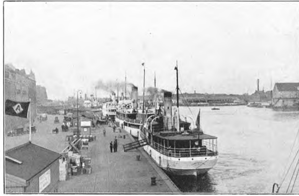
Anlæg af Øresundsbaadene ved Havnegade.
