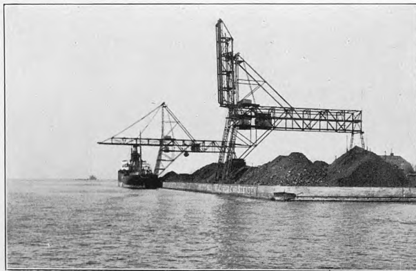
Revshaleøens Nordside med Københavns Bunkerkul Depots Kraner.
