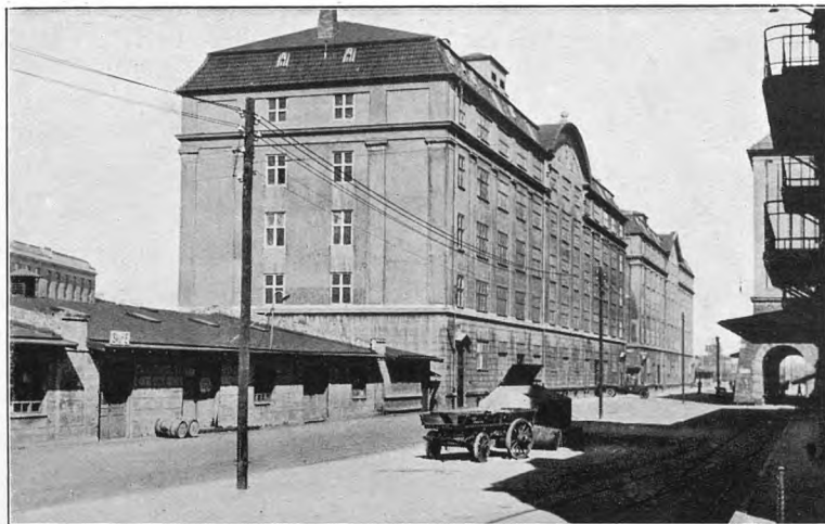
Dampfærgevej med Pakhusene C og D.
