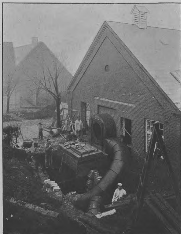
TRYKLUFTS OPVARMNINGS- OG VENTILATIONSANLÆG CARL ALLERS ETABLISSEMENT VALBY
