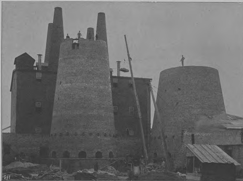
CEMENTFABRIK I OWEN SOUND, CANADA, BYGGET AF F. L. SMIDTH &amp; CO.
