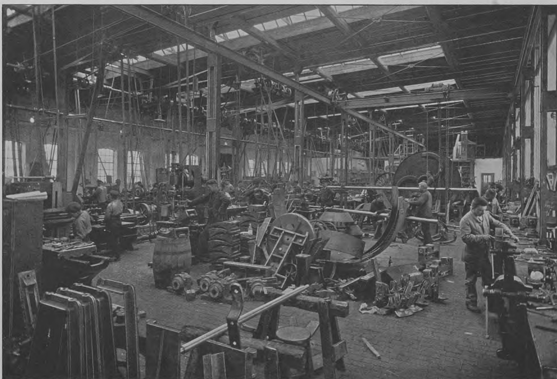
F. L. SMIDTH & CO.s MASKINFABRIK I VALBY — MASKINVÆRKSTED
