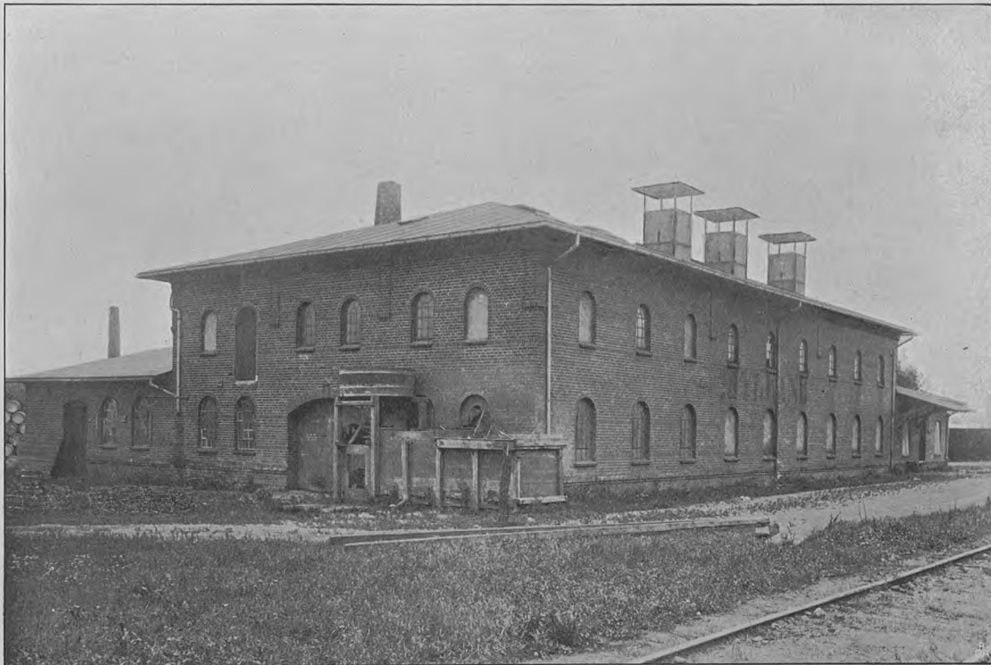
CICHORIETØRRERIET »JYLLAND«, KOLDING
