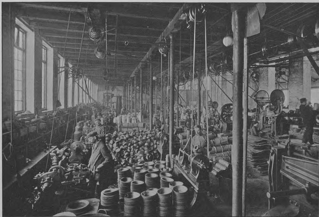
INTERIØR FRA MASKINHALLEN, FABRIKEN, FREDERIKSBORGVEJ
