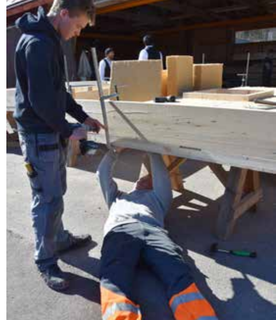
Norske Mathias Hvidsteen (16) og Magnus Thorsen (17) i gang med byggingen av passivhuset. Begge er glade for at de kom med på det norsk-tyske samarbeidsprosjektet.
