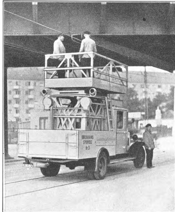
Fig. 75. Ledningsarbejde under Viadukt
