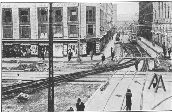
Fig. 62. Sporarbejder paa Raadhuspladsen ved Omlægningen 1931
