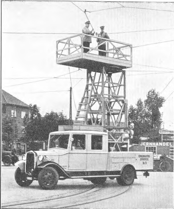
Fig. 74. Ledningsarbejde i normal Højde
