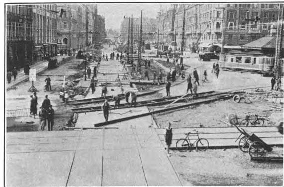
Fig. 63. Sporarbejder paa Raadhuspladsen ved Omlægningen 1931
