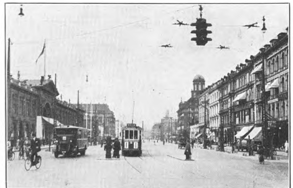
Fig. 65. Vesterbros Passage efter Omlægningen 1931, set fra Raadhuspladsen. Sporene er flyttet ind i Vejbanens Midte
