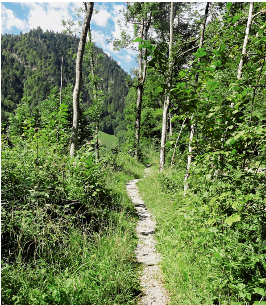
Bei optimal in das Terrain angelegtem Wegverlauf und regelmässigem Unterhalt – auslichten, punktuell Aufschütten von Kies – kann ein Wanderweg über längere Zeit problemlos erhalten werden.
