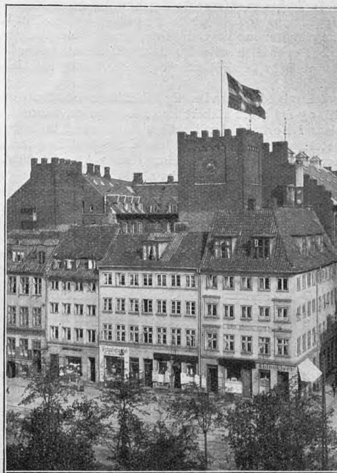
K. F. U. M.'s Bygning, set fra Nørrevoldgade.
