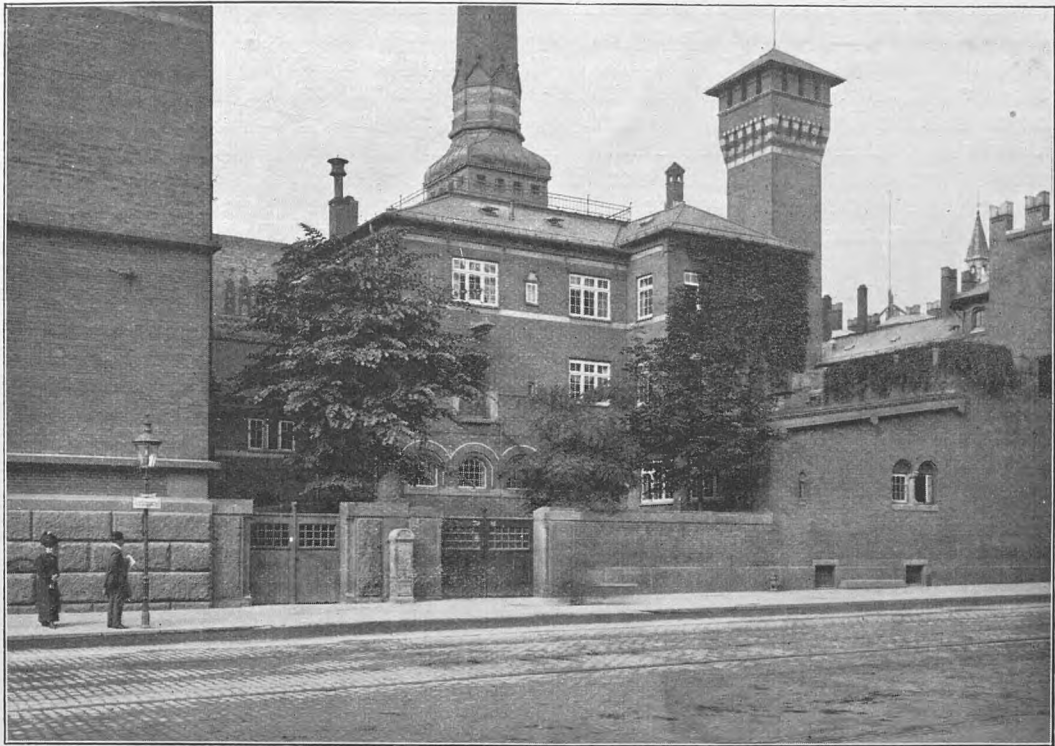
Eksempler paa godt placerede Træer: Ved Raadhusets Kedelanlæg i Vestervoldgade
