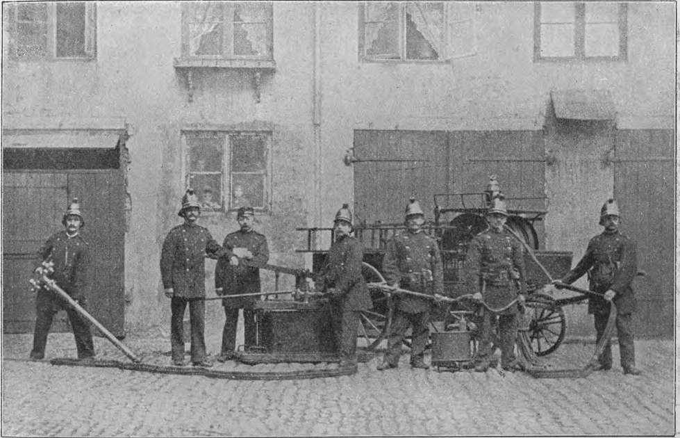
Stationen i Hotel »Phoenix«. Foto fra 1870.
